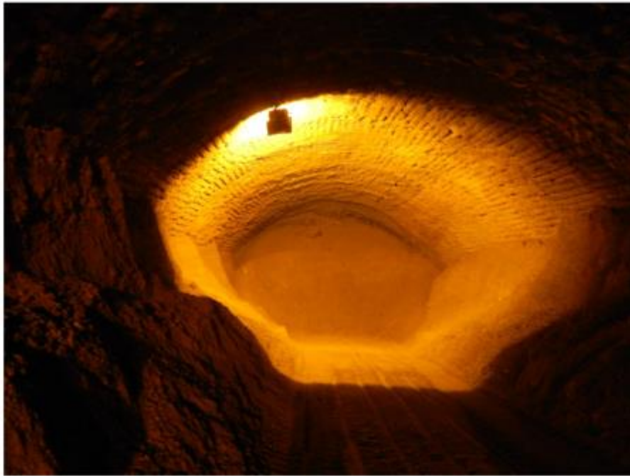
نگاره ۱: ابتدای محل ریزش در تونل مراجع. همانگونه که دیده می شود حفاری و تحکیم تونل بنا به گفته پیمانکار یک ماه پیش انجام گرفته است. دید به سوی جنوب
