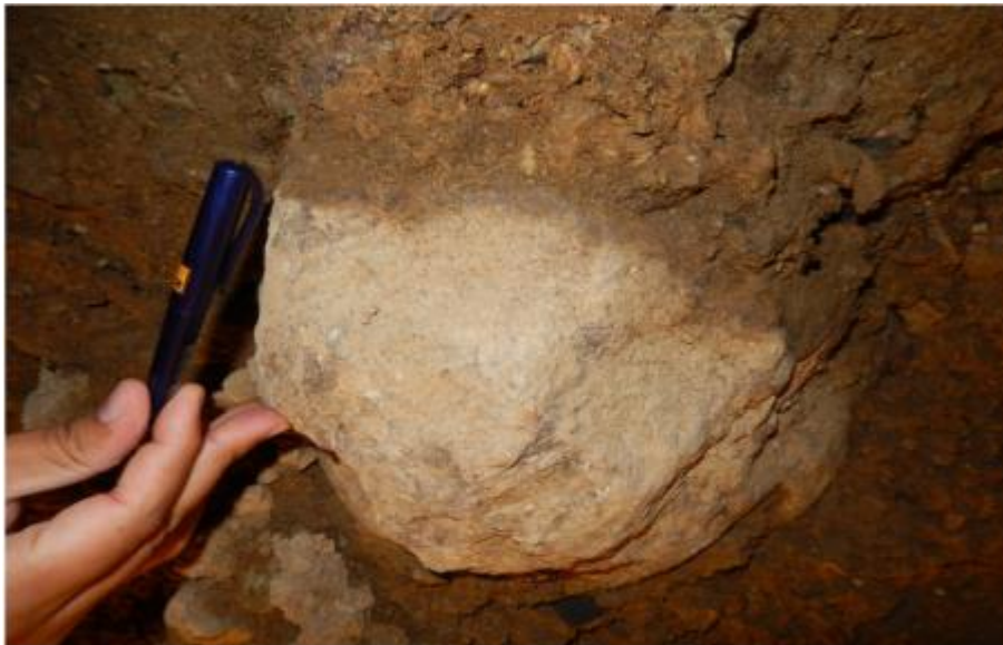
نگاره ۴: گاری دسترسی به اتاق برق ایستگاه آهناسان. نمونه ای از قلوه سنگهای موجود در خاک. حرکت آن ها بر اثر نشستهای کوچک می تواند به ایجاد حفره و در نتیجه ریزش های بزرگتر منجر شود.
