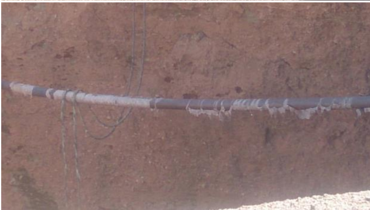
شکل ۱۳- وضعیت لوله‌ها و ریزش آب به درون حفره
