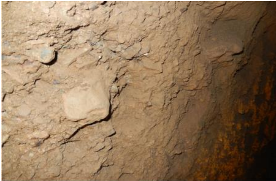
نگاره ۵: گلری دسترسی به اتاق برق ایستگاه آهنگسان. قلوه سنگهای بسیار در آبرفت بدون اینکه خاک زمینه دارای چسبندگی باشد. حفاری در این خاک نیاز به دقت بسیار دارد و باید از هرگونه سرعت در اجرا دوری کرد.
