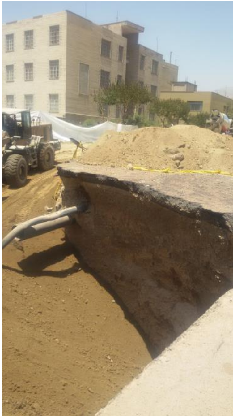
شکل ۱۸- عکس‌هایی از نحوه خاک ریزی و پر نمودن حفره ناشی از فروریزش ایجاد شده در منطقه شهران
