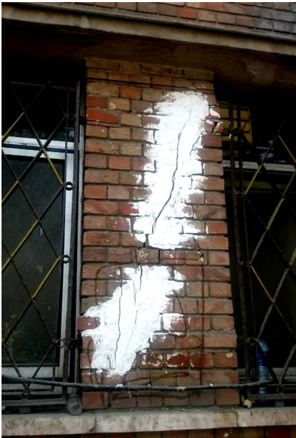
شکل ۸- بروز ترک برشی در نمای بیرونی ساختمان بیمارستان
