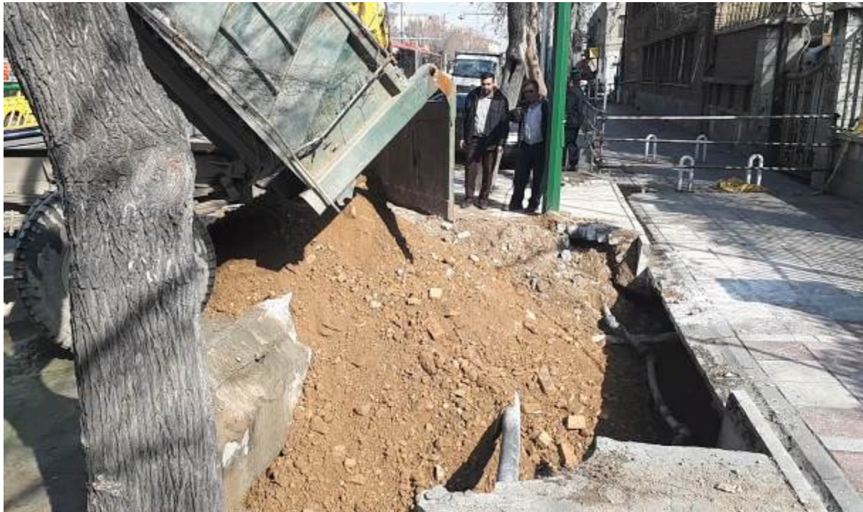
شکل ۸- نوع دانه بندی خاک و نحوه خاکریزی حفره ایجاد شده
