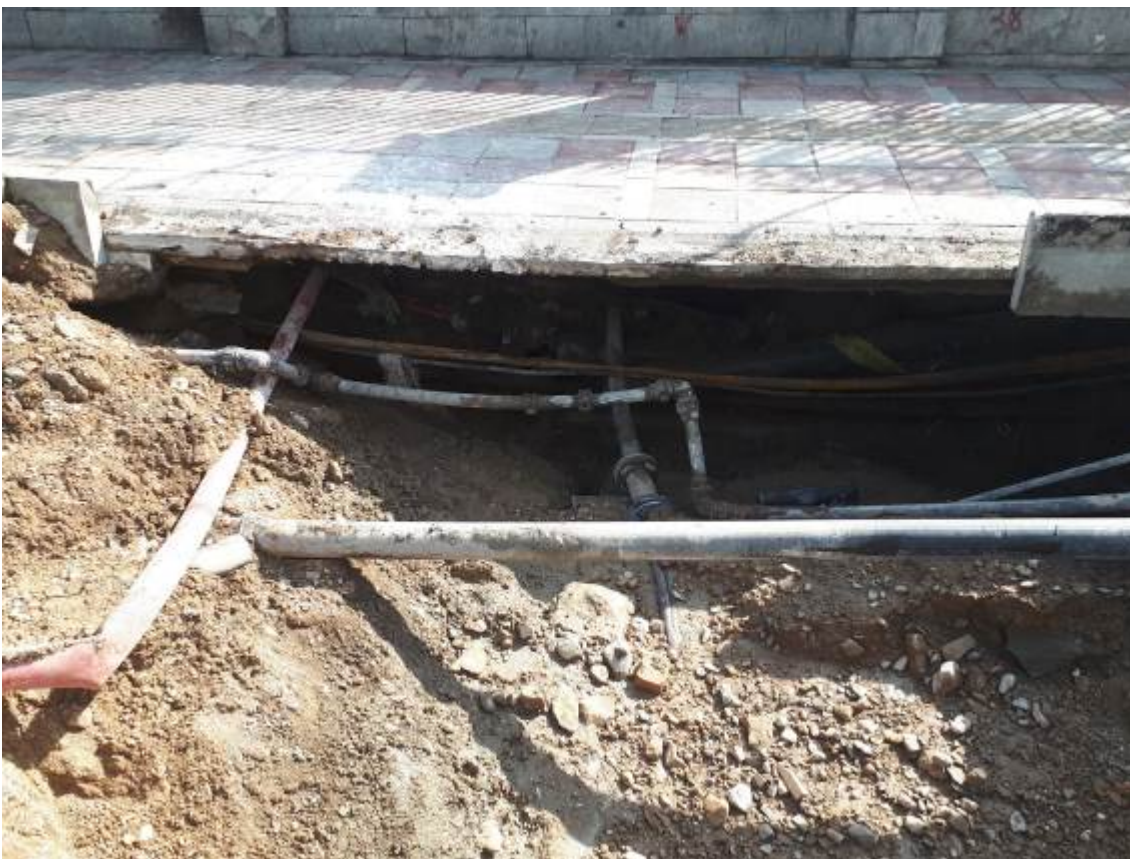
شکل ۳- ابعاد حفره و فضای خالی زیر موزائیک کاری پیاده رو ضلع جنوبی خیابان مولوی ( عکس اکیپ مرکز ۹۶/۱۲/۶)
