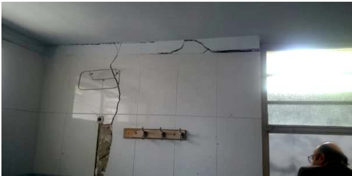
شکل ۳- آسیب‌های وارده به سرویس‌های بهداشتی در بخش شرقی بیمارستان
