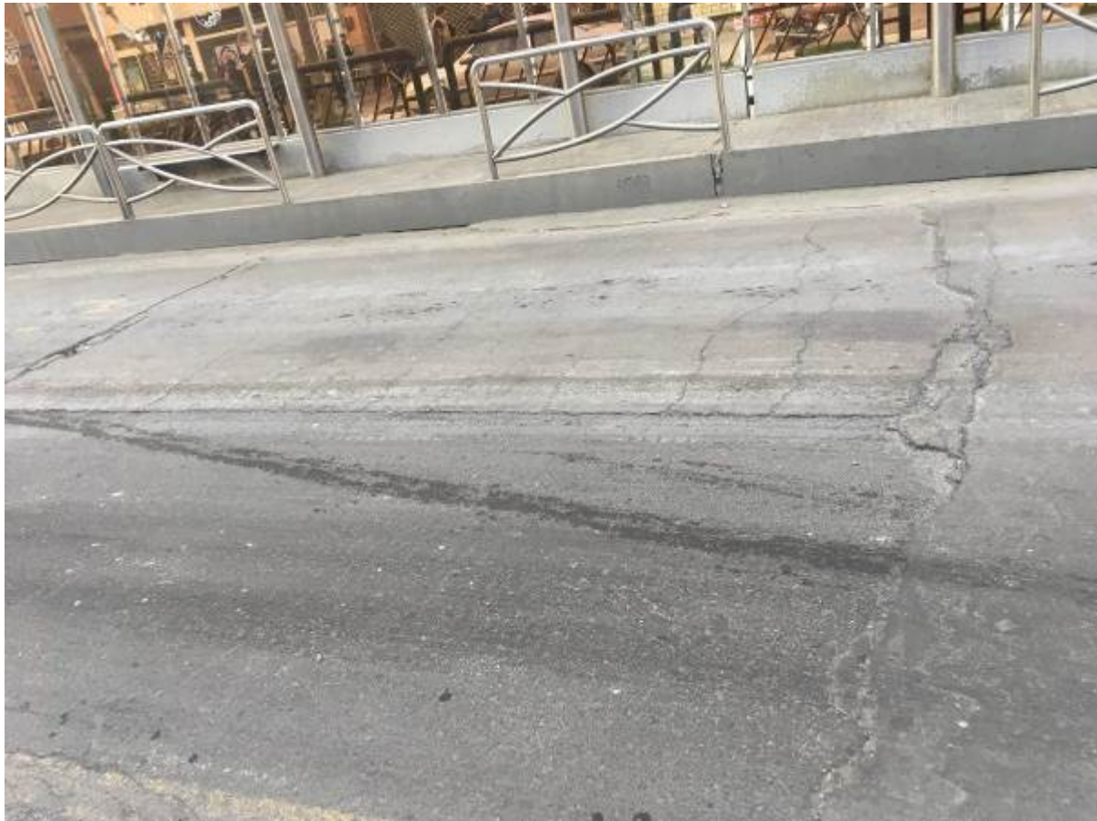
شکل ۱۲- خسارت‌های وارده بر ساختمان‌های اطراف نقطه فروریزش
