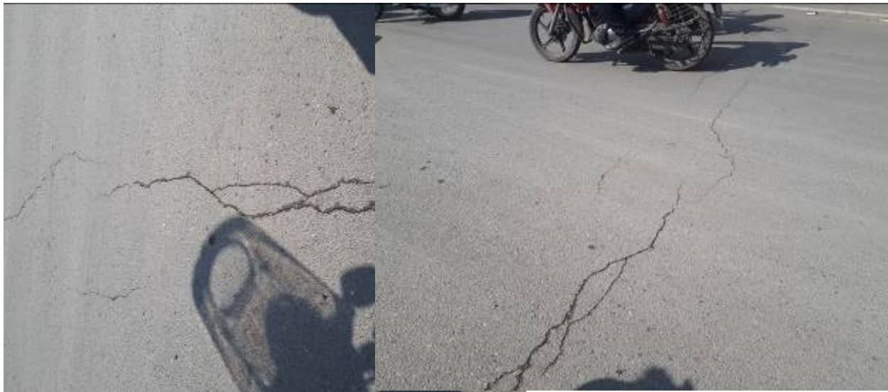
شکل ۱۰- ترک های متعدد مشاهده شده در کف خیابان در مجاورت نقطه فروریزش زمین
