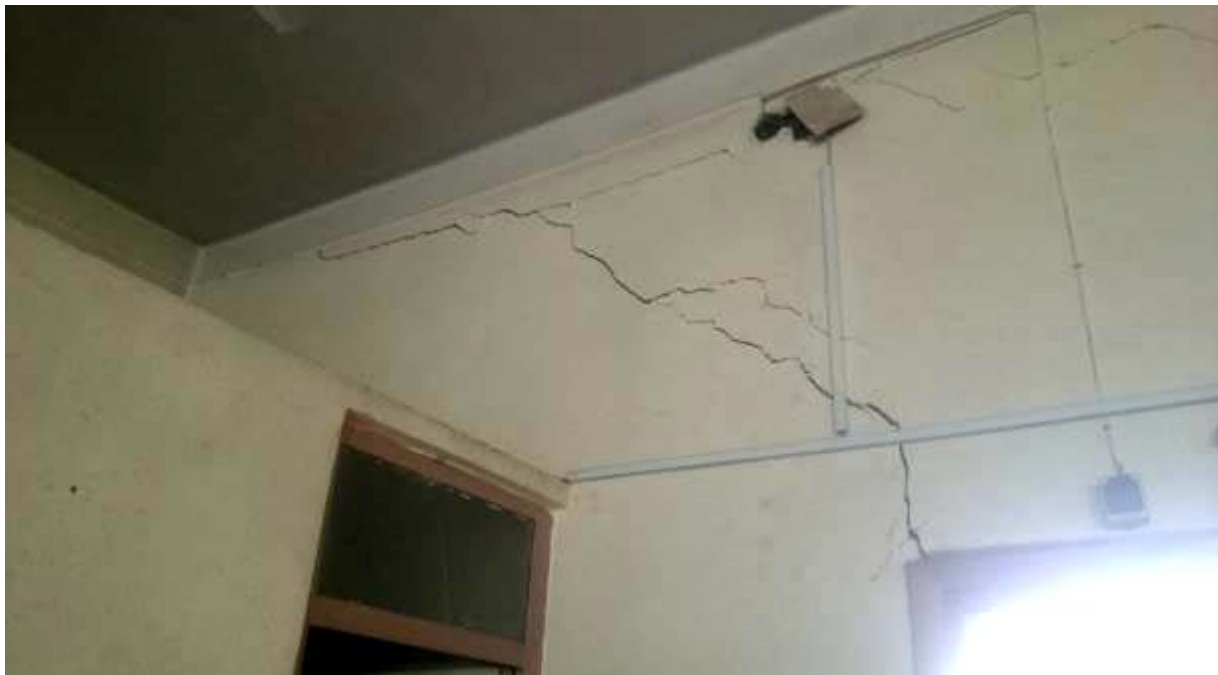
شکل ۶- بروز ترک در دیواره در بخش شرقی ساختمان بیمارستان
