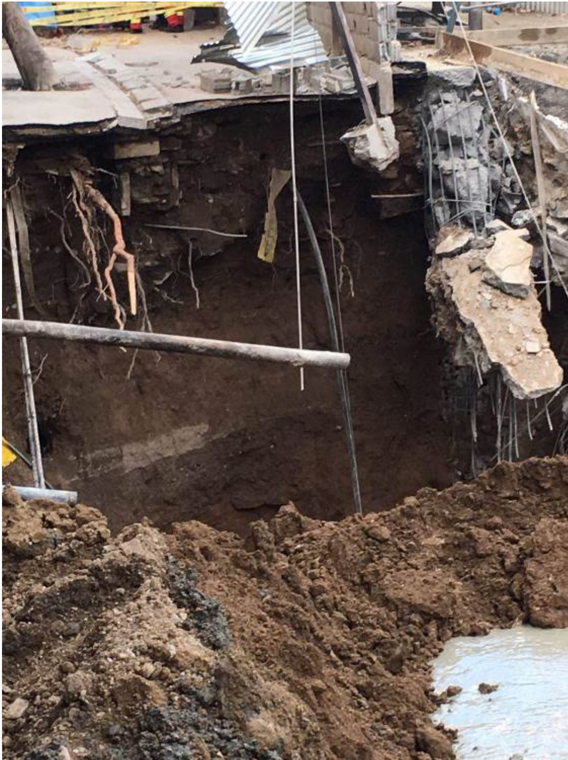
شکل ۷- لوله‌های و کابل‌های موجود در گودال ایجاد شده محل حادثه
