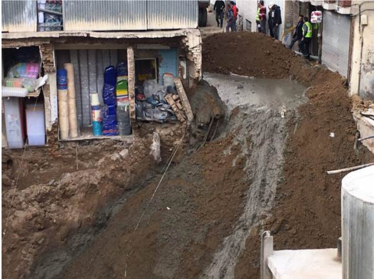
شکل ۶- پرنمودن حفره ایجاد شده با مصالح سیمانی
