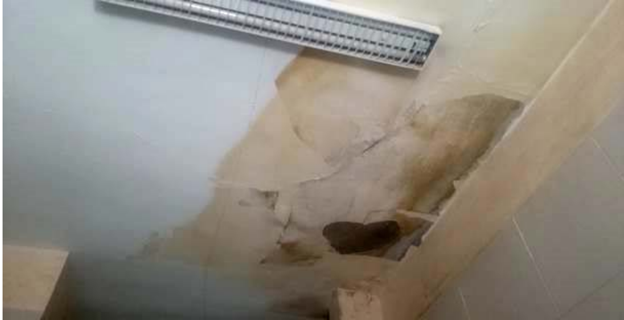
شکل ۵- نشست آب در سقف بخش شرقی ساختمان ناشی از ارتعاش تجهیزات مترو
