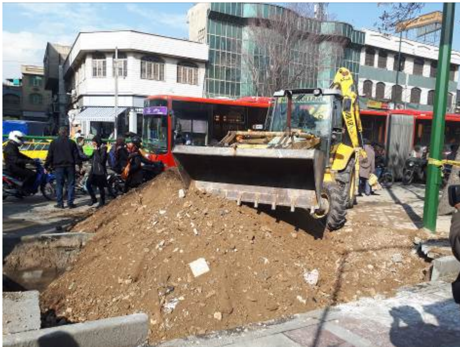
شکل ۹- پر کردن حفره ناشی از فروریزش زمین با استفاده از لودر
