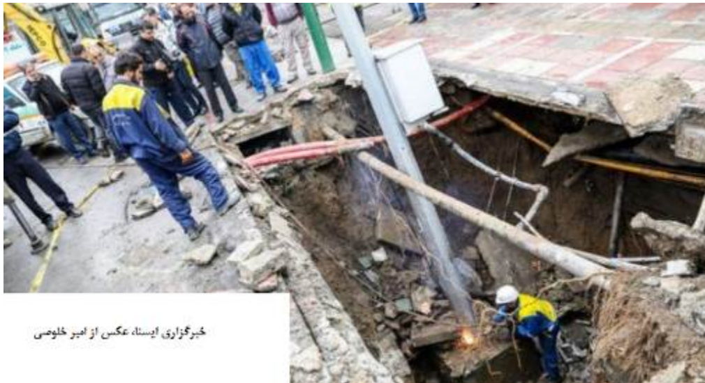
شکل ۴- تیر کنترل ترافیک آسیب دیده در اثر فروریزش زمین
