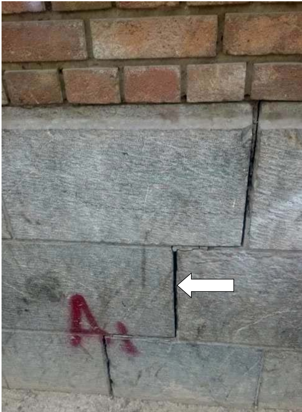
شکل ۷- بروز جدایی مابین مصالح جدار بیرونی ساختمان ناشی از تغییر مکان
