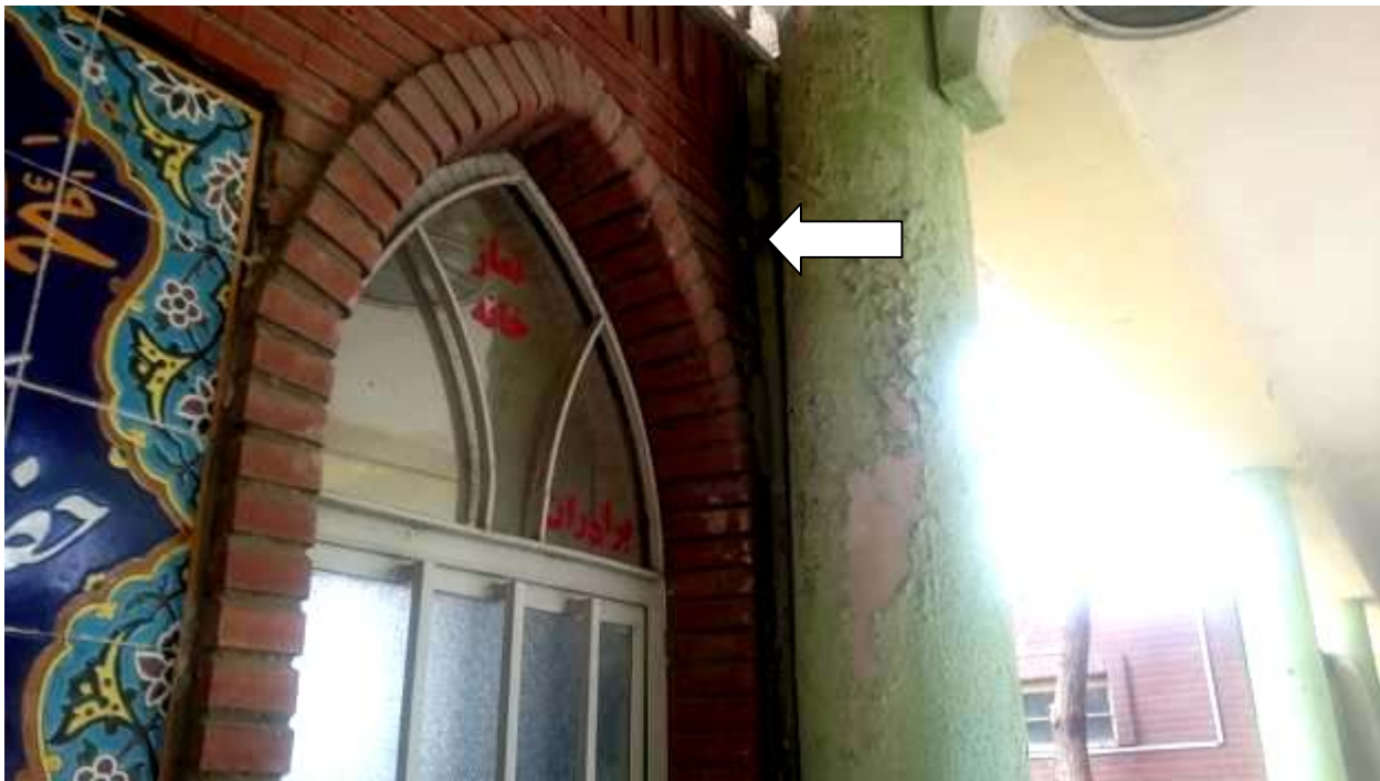
شکل ۹- جداشدگی مابین دیوار و ستون به دلیل وقوع پدید چرخش دیوار حول پایه
