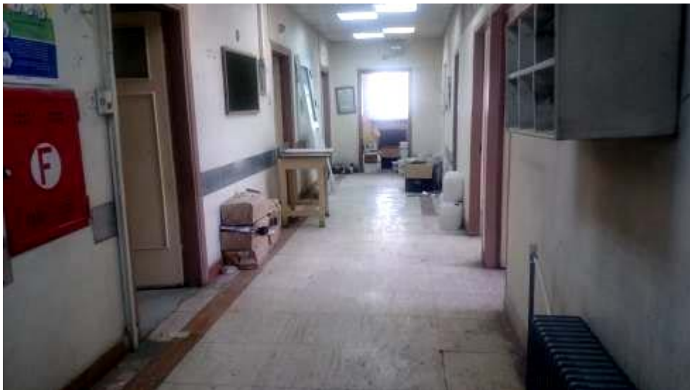
شکل ۲- بخش تخلیه شده در ساختمان بیمارستان ناشی از آسیب‌های وارد شده
