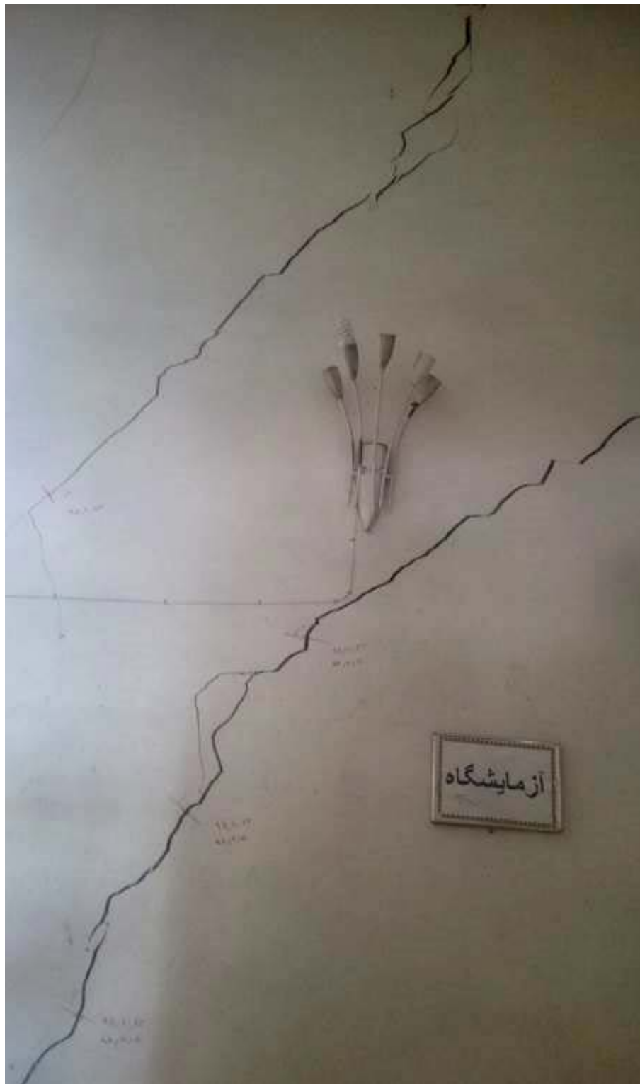
شکل ۱۵- بروز ترک برشی چهل و پنج عمیق در دیوارهای بخش شرقی ساختمان
