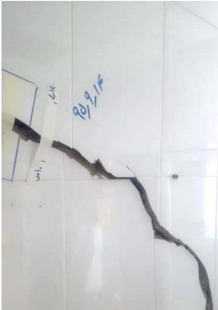
شکل ۱۴- بروز ترک برشی چهل و پنج عمیق در دیوارهای بخش غربی ساختمان
