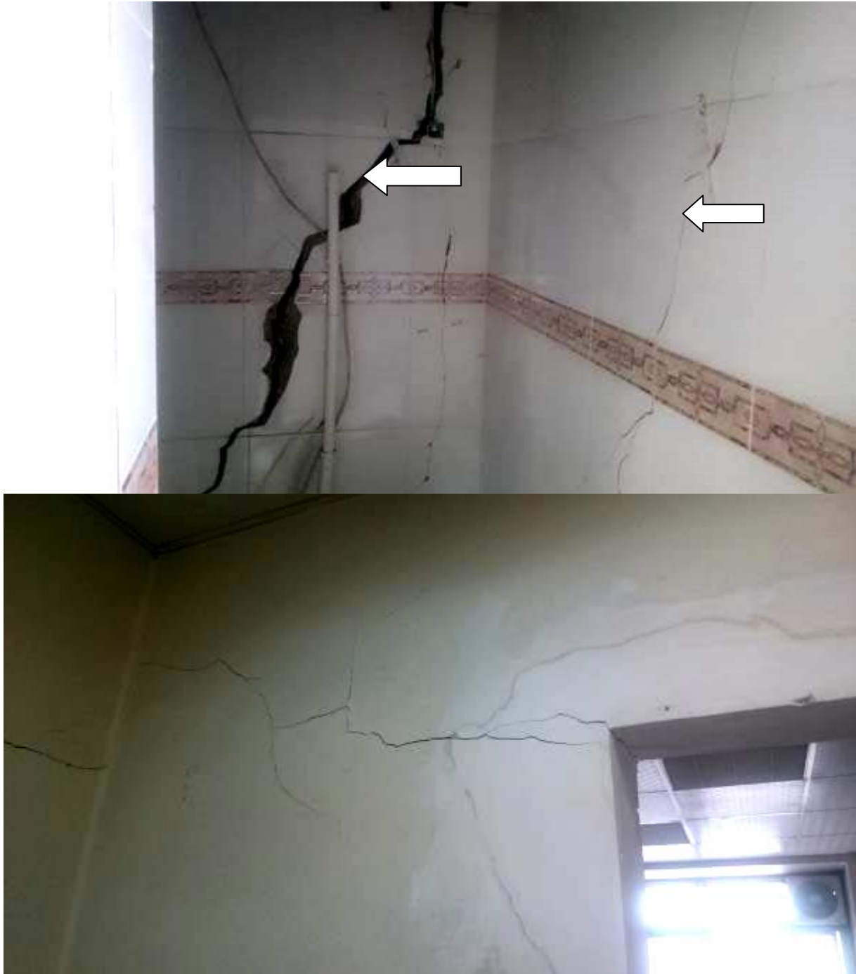
شکل ۱۳- بروز ترک برشی چهل و پنج درجه و تخریب در دیوارهای بخش غربی ساختمان
