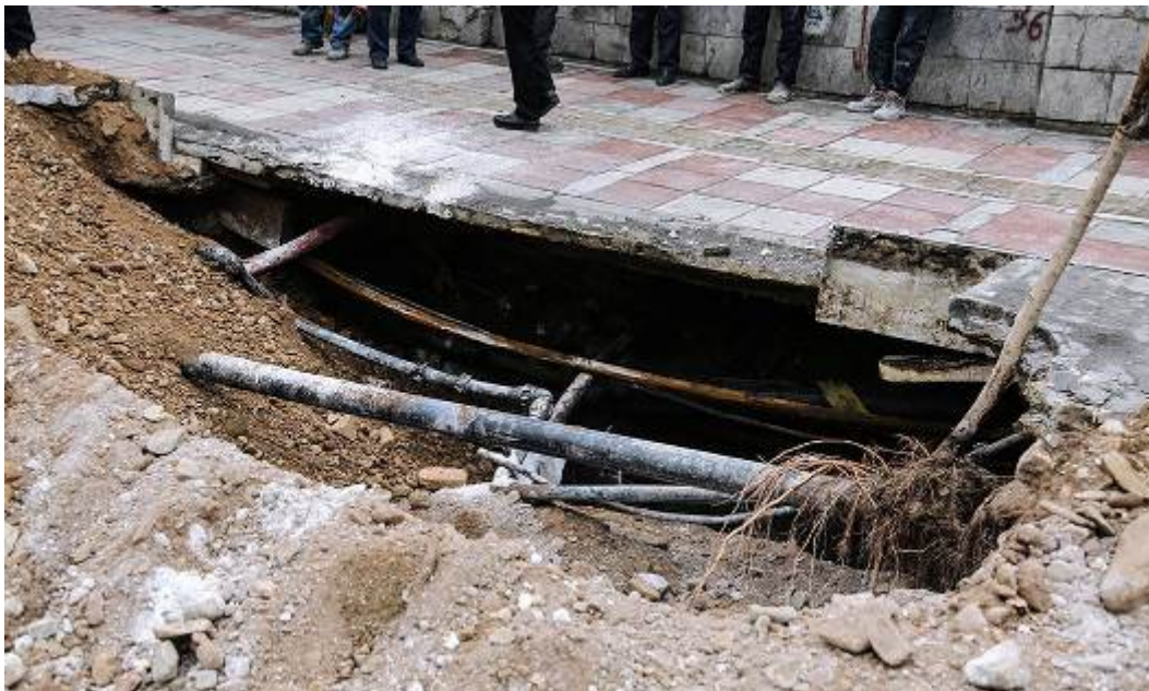
شکل ۵- درختچه از جا کنده شده در اثر فروریزش زمین واقع در مسیر پیاده رو جنوبی خیابان مولوی ( عکس اکیب مرکز)
