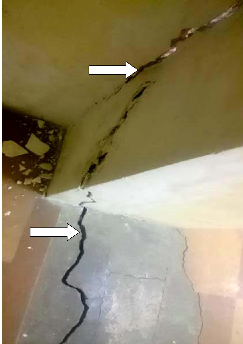
شکل ۱۰- بروز جدانشدگی مابین دیوارها
