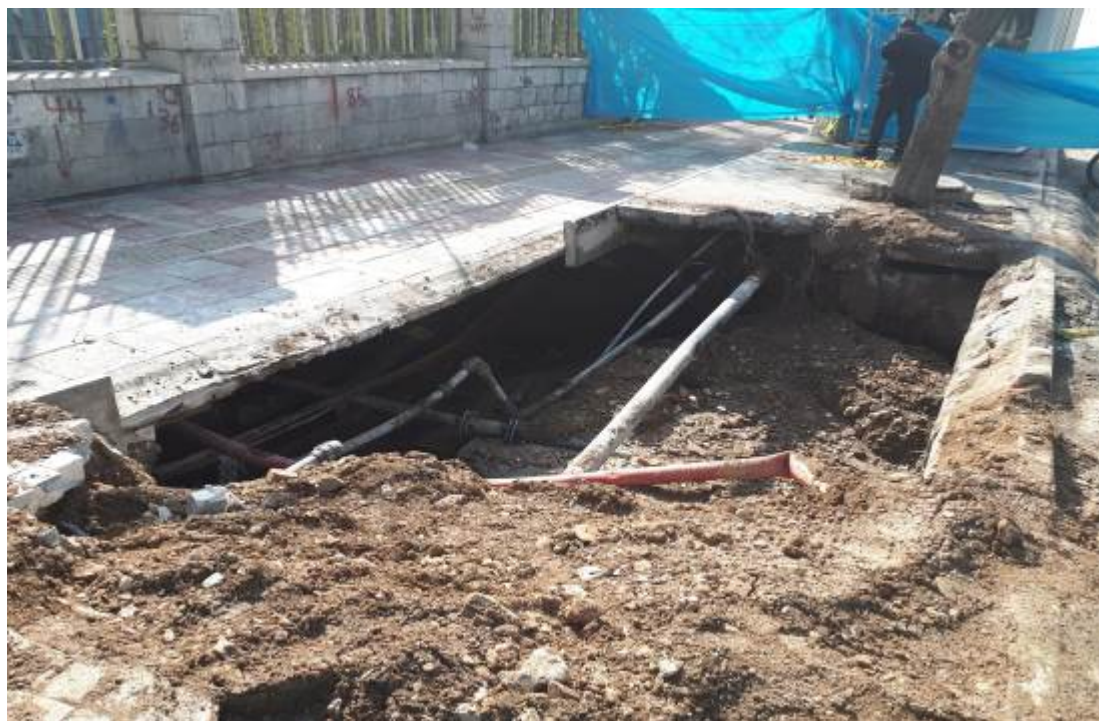
شکل ۷- لوله ها و خطوط موجود در محدوده زون فروریزشی خیابان مولوی ۱۳۹۶/۱۲/۶ (لوله خمیده فلزی در شکل دیده می شود)
