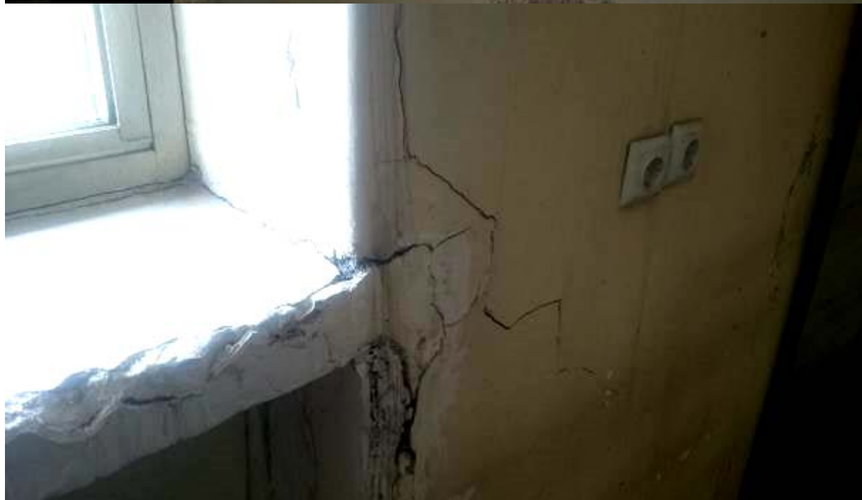
شکل ۱۲- بروز ترک برشی چهل و پنج درجه در دیوارها و کنار بازشوها
