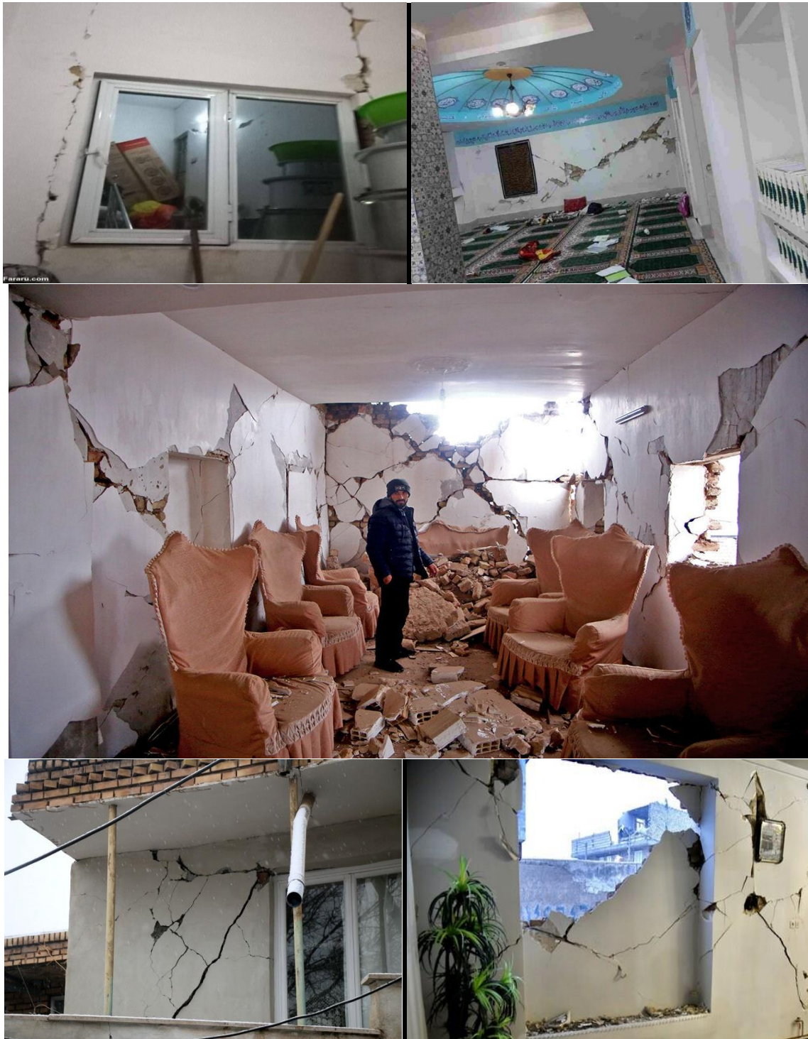
شکل ۲-۲- بروز ترک‌های برشی و خطوط گسیختگی در دیوارهای برخی ساختمان‌ها
