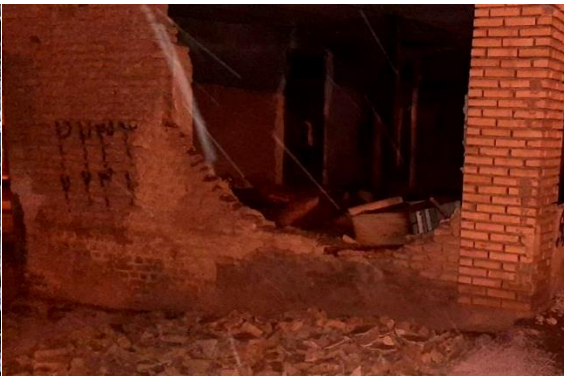
شکل ۲-۵- نمونه‌هایی از ریزش دیوار منازل و محوطه‌ها در اثر زلزله خوی
