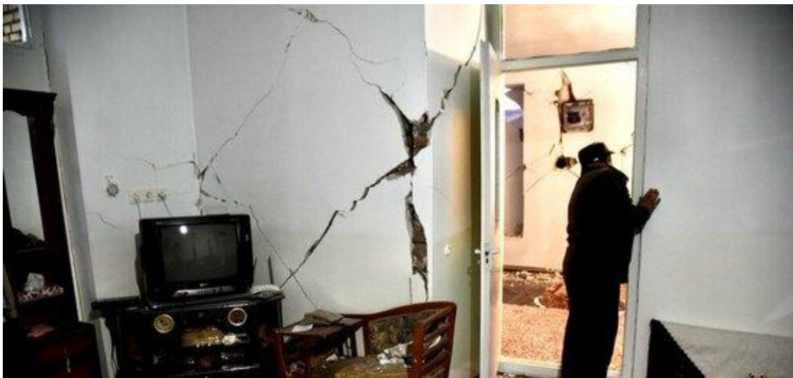
شکل ۲-۸- نمونه‌هایی از ترک‌های برشی ناشی از زلزله در دیوار برخی منازل مسکونی
