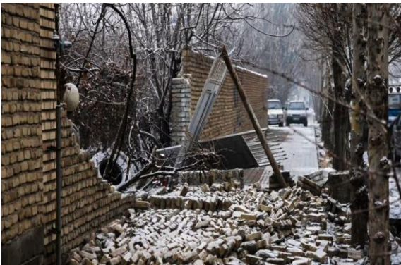
شکل ۲-۵- نمونه‌هایی از ریزش دیوار منازل و محوطه‌ها در اثر زلزله خوی
