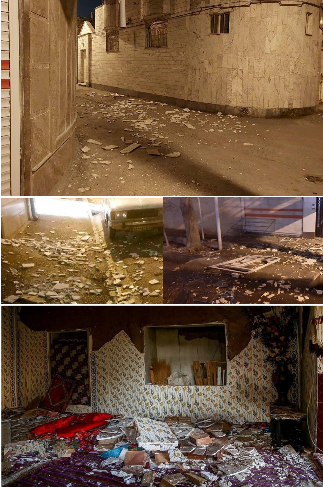
شکل ۲-۴- نمونه‌هایی از ریزش قطعات نمای داخلی و خارجی و پوشش برخی دیوارها در اثر زلزله
