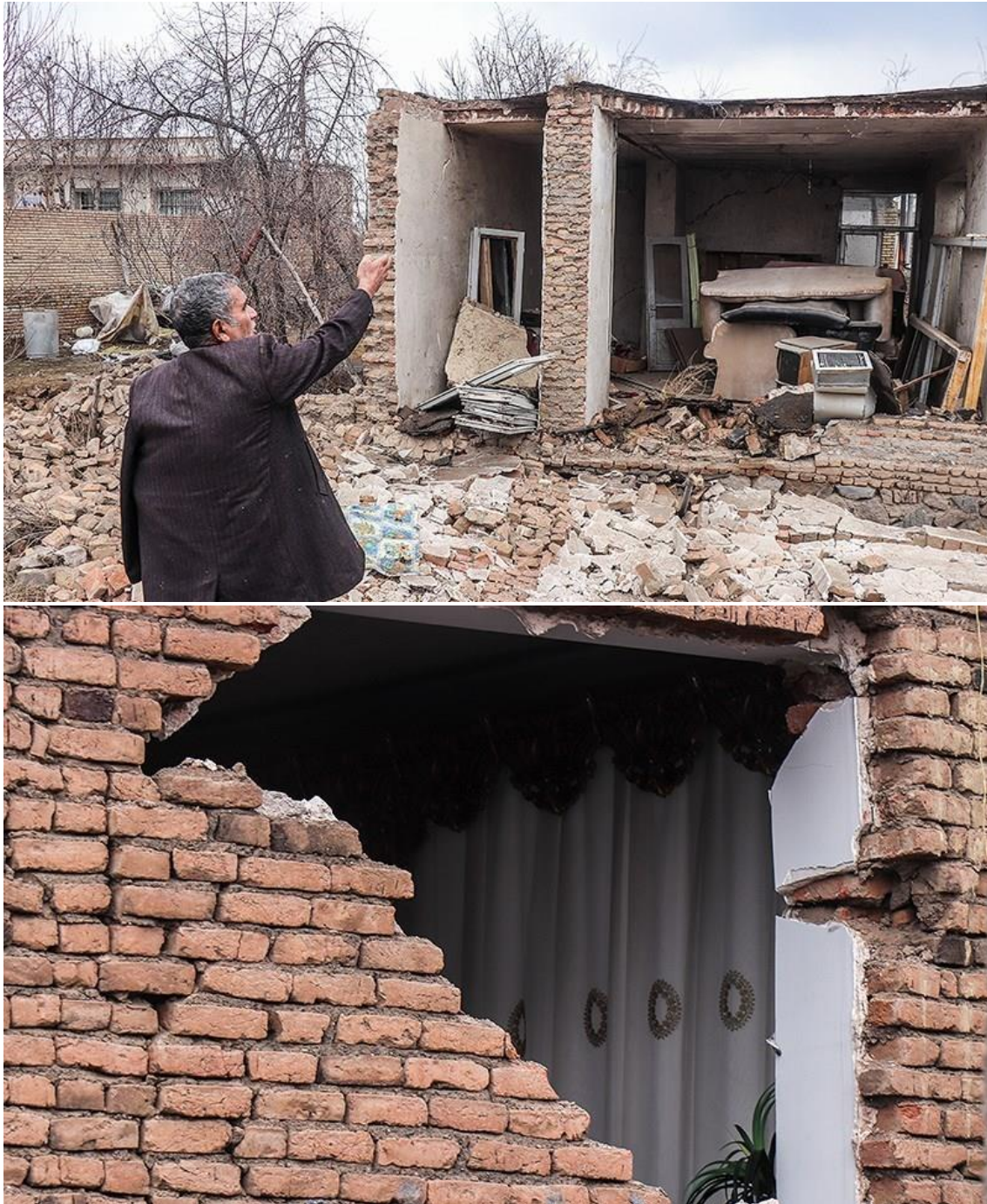
شکل ۲-۷- واژگونی برخی دیوارهای غیرباربر در ساختمان‌های مصالح بنایی در اثر زلزله
