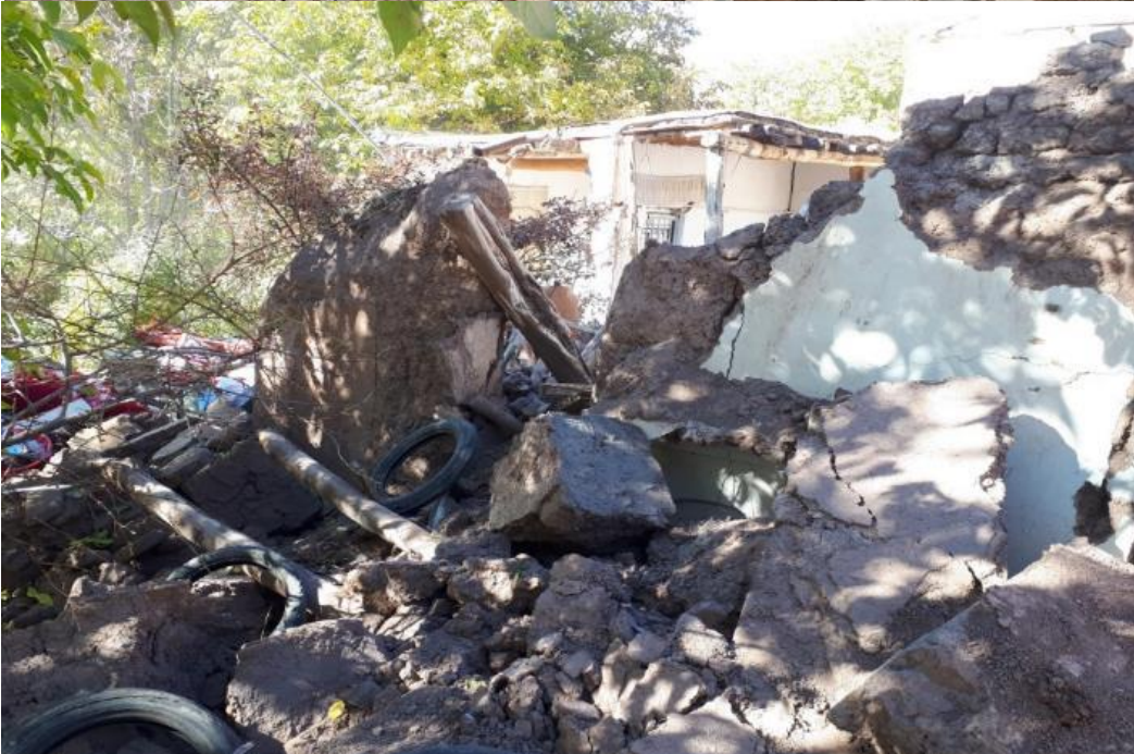
شکل ۲۹-۲ تخریب کامل سازه بنایی بدون کلاف (خشتی و سنگی) در ورنکش
