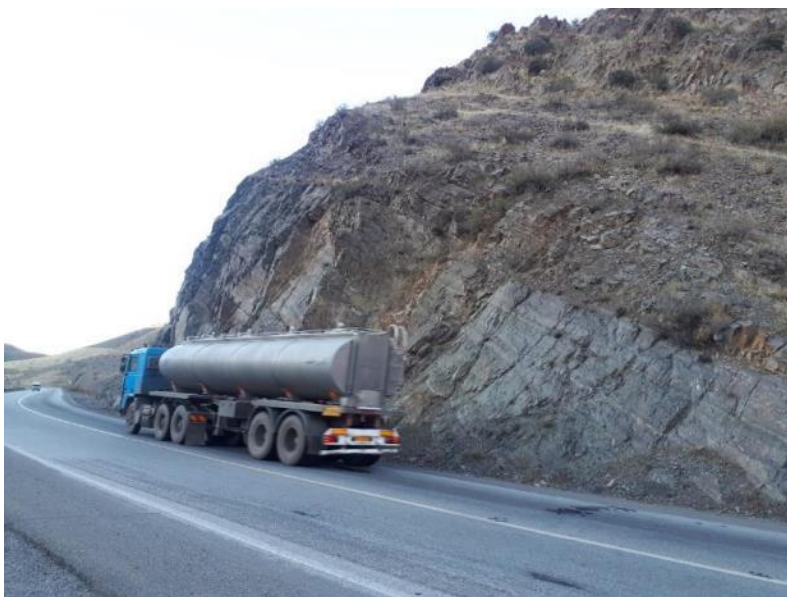
شکل ۹-۳ محور میانه - بستن آباد بعد از عملیات پاکسازی از واریزه های سنگی
