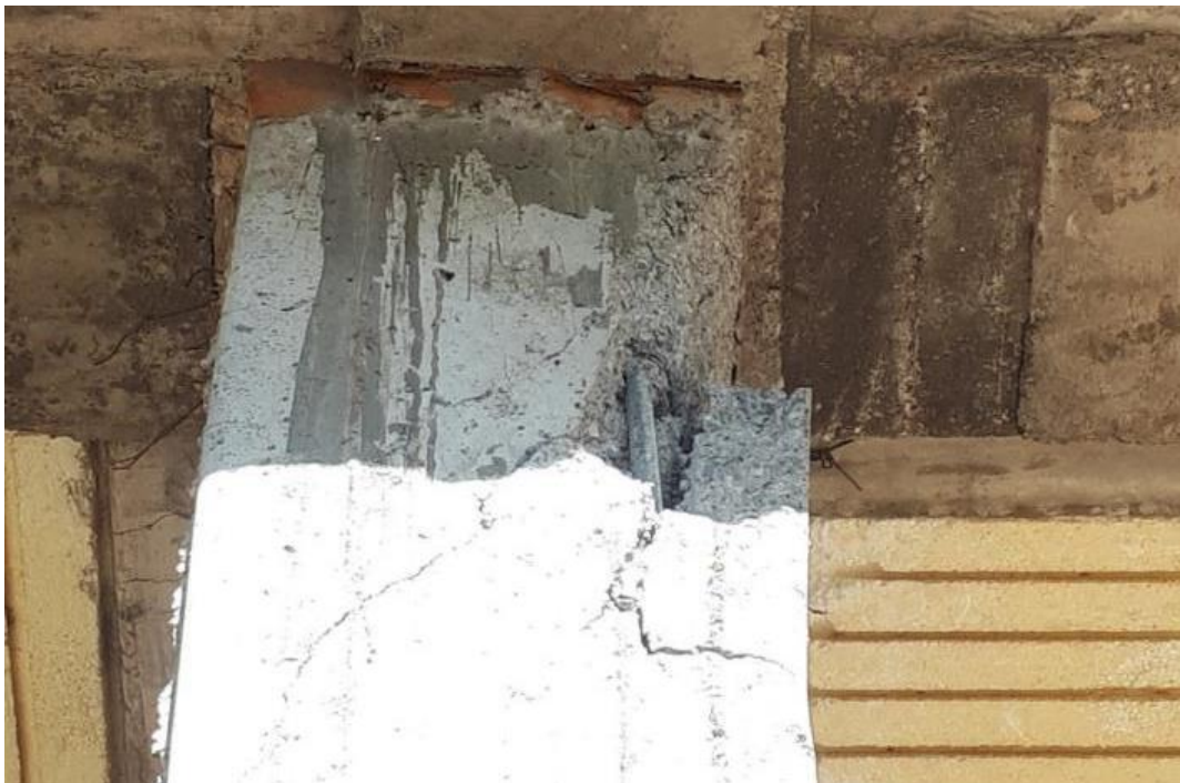
شکل ۴۶-۲ آسیب در کاور ستون در ساختمان اسکلت بتنی به دلیل ضعف اجرایی و اتصال نامناسب تیر و ستون
