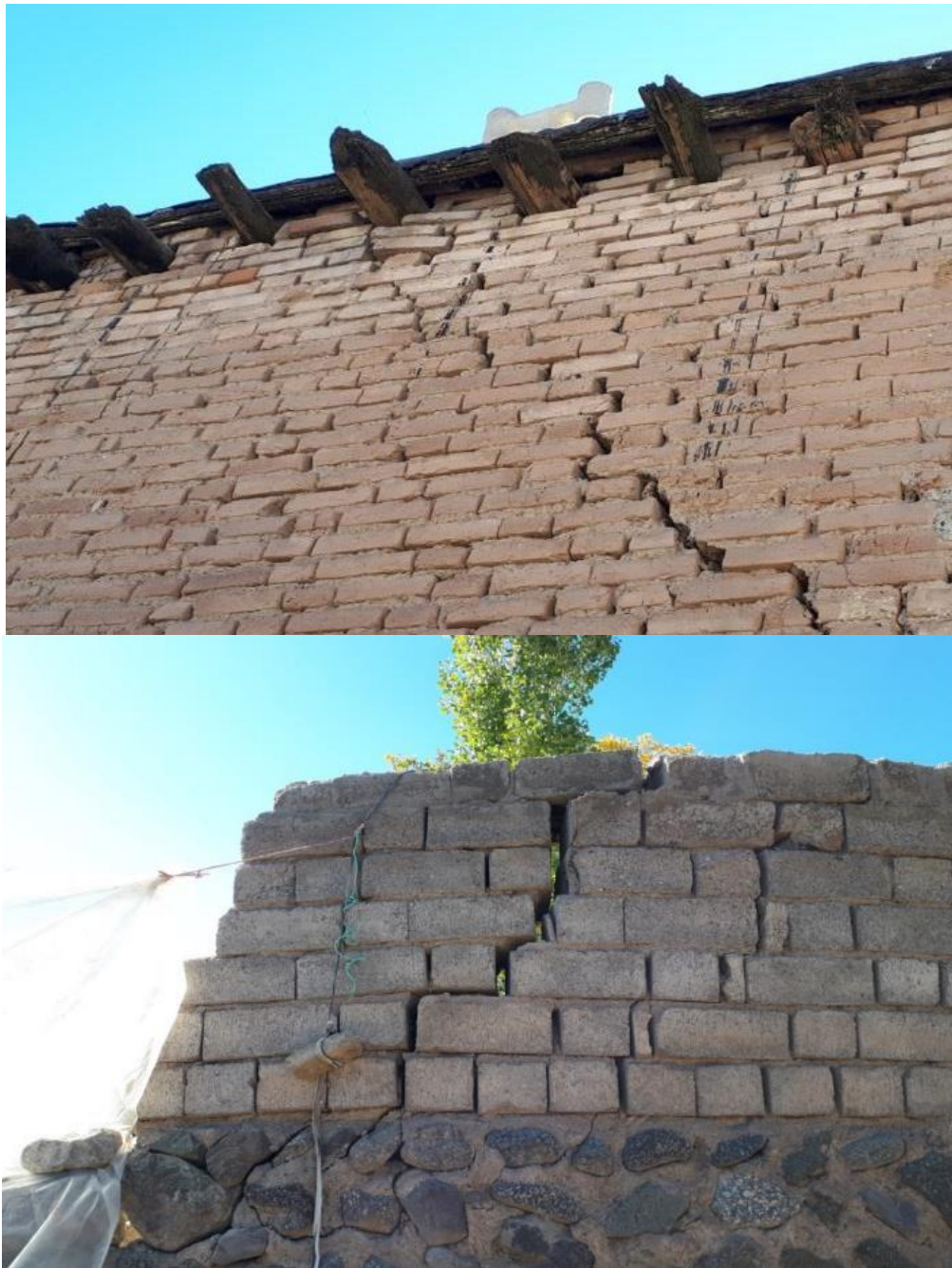
شکل ۶-۲ بروز گسیختگی پلکانی در دیوار ساختمان مصالح بنایی
