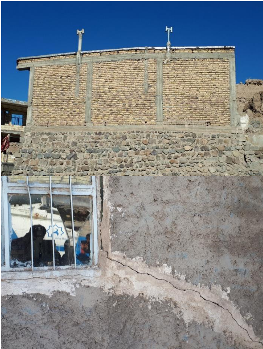
شکل ۱۴-۲ رفتار لرزه ای خوب و آسیب اندک ساختمان های کلاف دار در روستای بالسین
