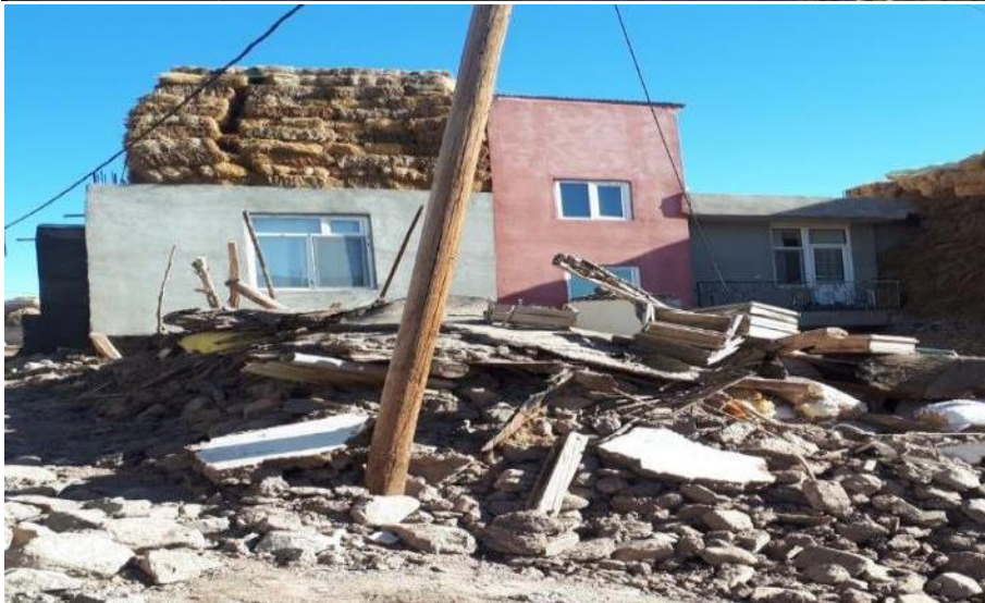
شکل ۴۹-۲ مقایسه رفتار لرزه ای سازه اسکلت دار و سازه بنایی بدون کلاف در ورنکش
