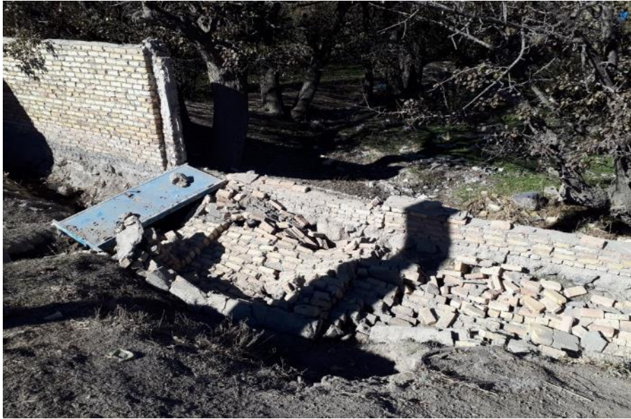
شکل ۶۷-۲ ریزش دیوار محوطه ها به دلیل عدم وجود کلاف و درز انقطاع در این دیوارها
