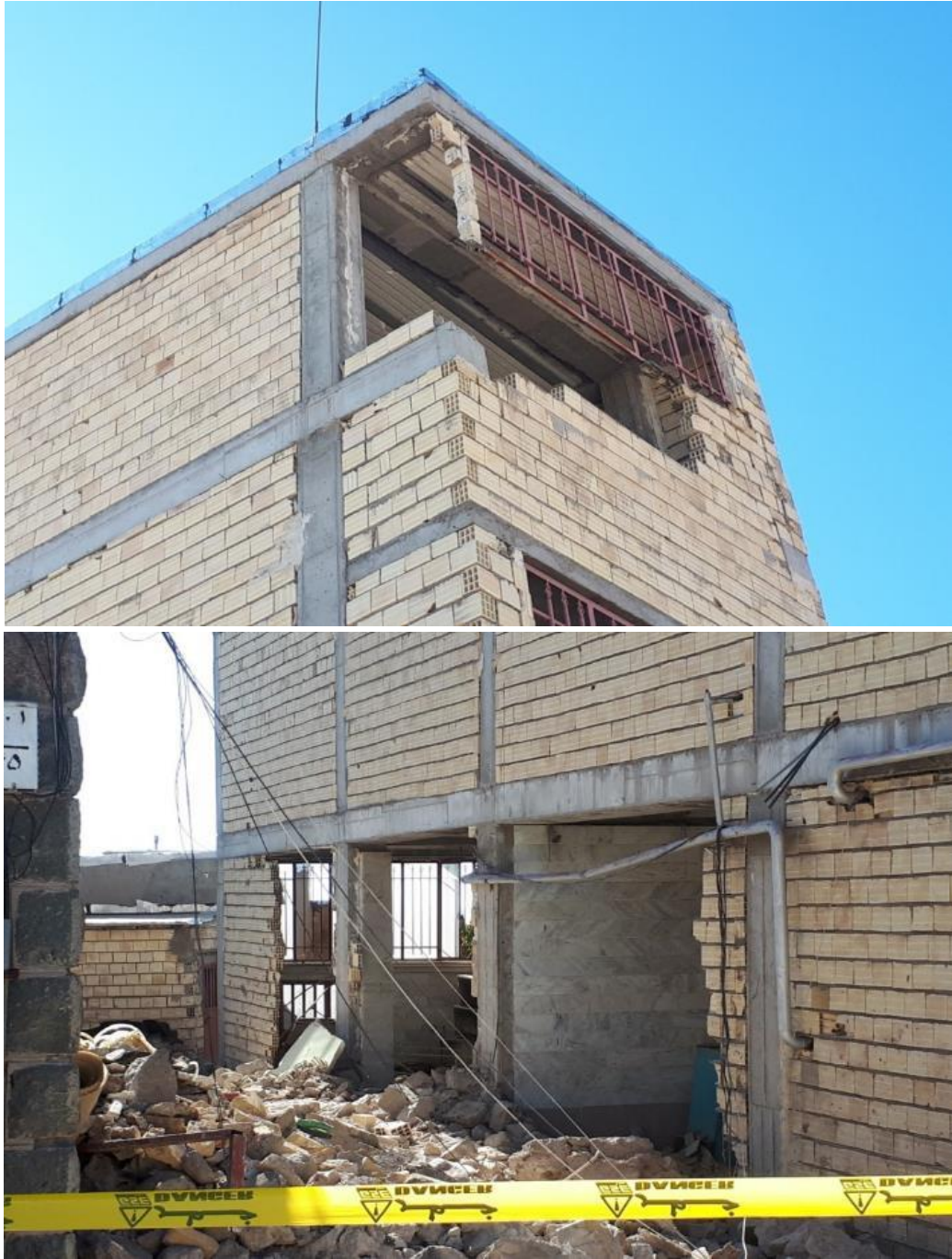
شکل ۵۱-۲ ریزش مصالح دیوارهای سازه اسکلت دار در ورنکش (عدم وجود مهار و اتصال مناسب)
