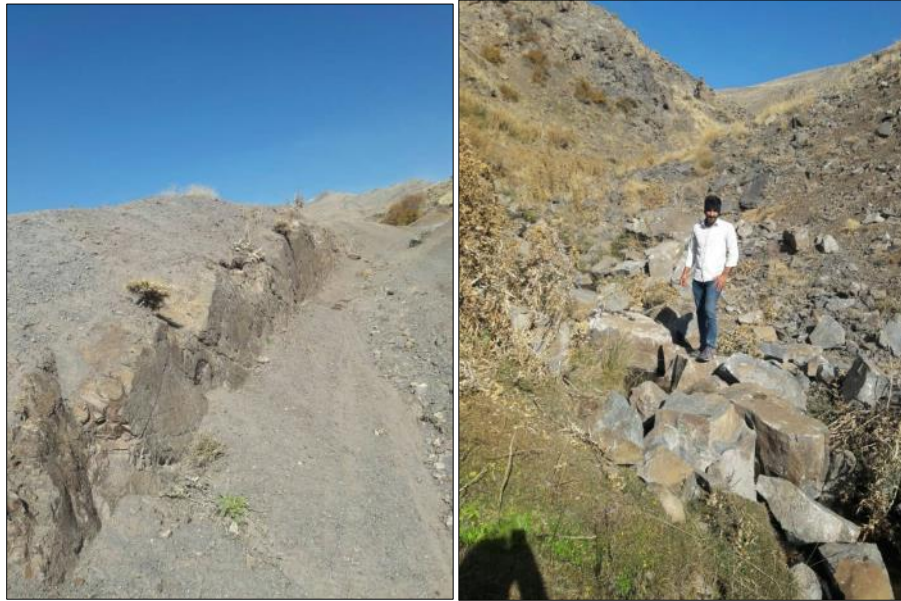
شکل ۱-۳۰ رخنمون گسلش در منطقه رومرکز زلزله
