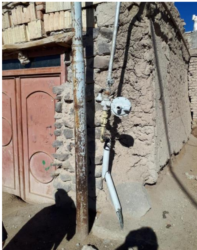
شکل ۲-۳ شکست علمک گاز در اثر تخریب دیوار مجاور در زلزله و ایراد ضربه به بدنه علمک
