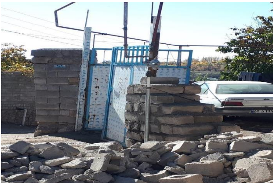
شکل ۲۴-۲ علمک آسیب دیده در منطقه بالسین بر اثر ریزش دیوار مجاور
