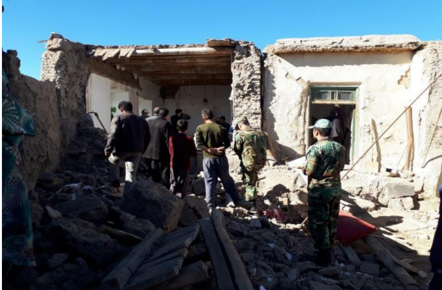
شکل ۶۰-۲ واژگونی دیوار موازی تیرریزی سقف
