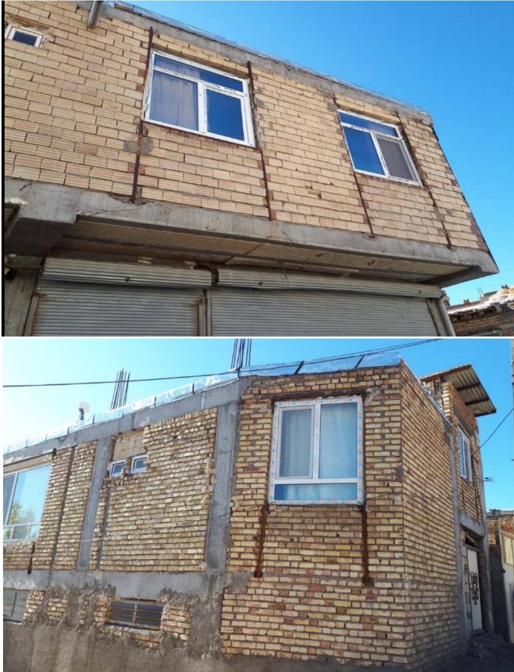
شکل ۲-۵۰ حفظ پنجره و دیوارها با تکنیک های ساده مهار (البته ضوابط اجرایی به شکل کامل رعایت نشده است)
