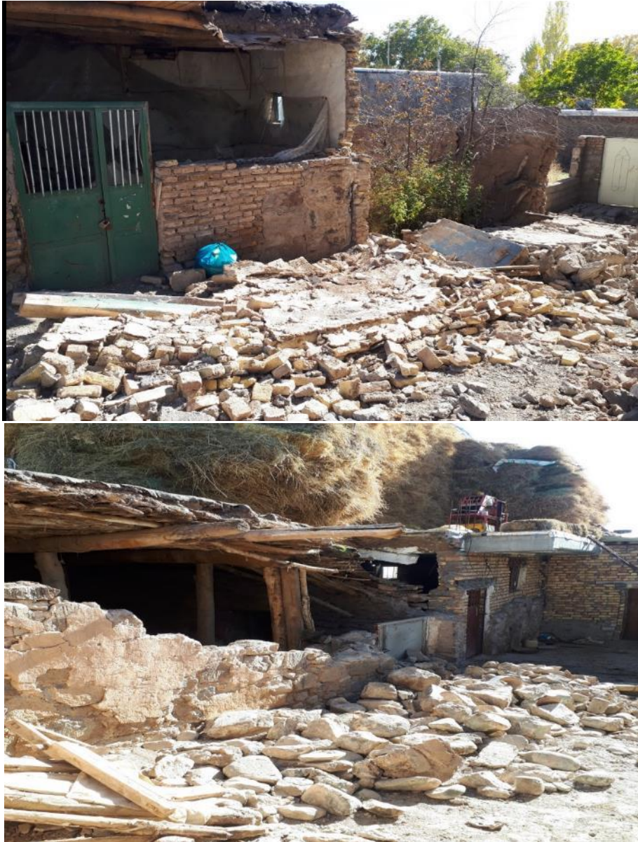
شکل ۳۷-۲ تخریب دیوار به دلیل عدم اتصال مناسب با سقف
