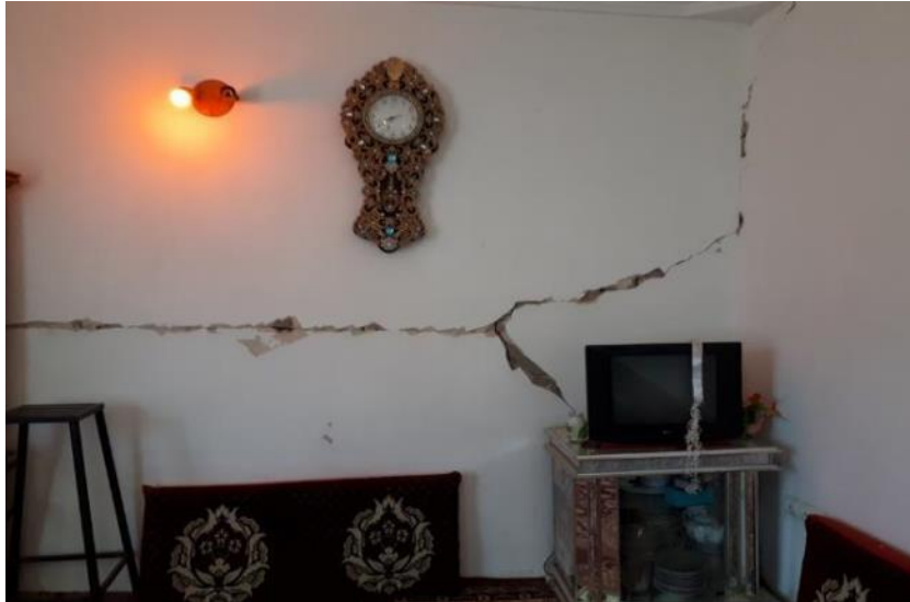
شکل ۷۱-۲ ترک خوردگی دیوارهای ساختمان سازه بنایی با کلاف افقی
