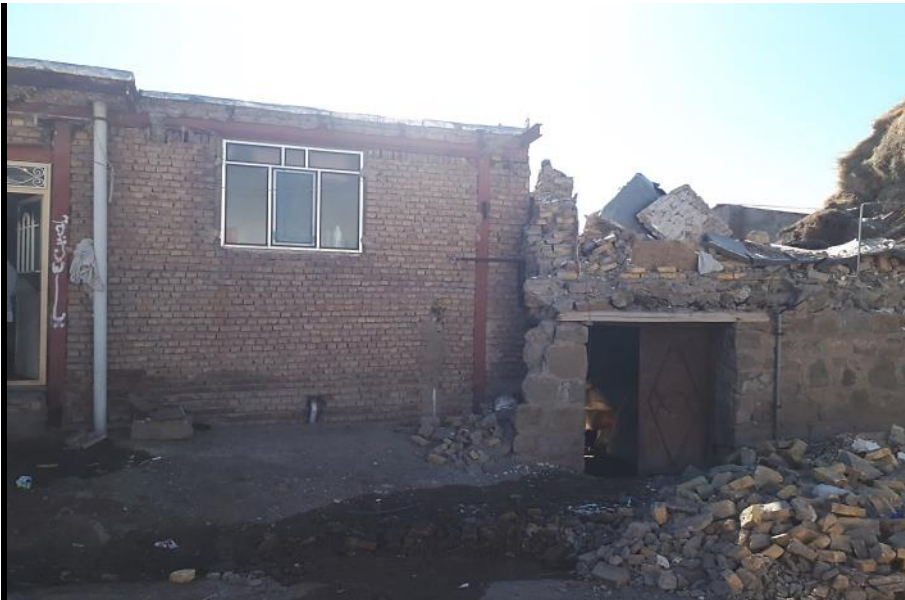
شکل ۴۸-۲ مقایسه رفتار لرزه ای سازه بنایی بدون کلاف و سازه اسکلت دار در ورنکش
