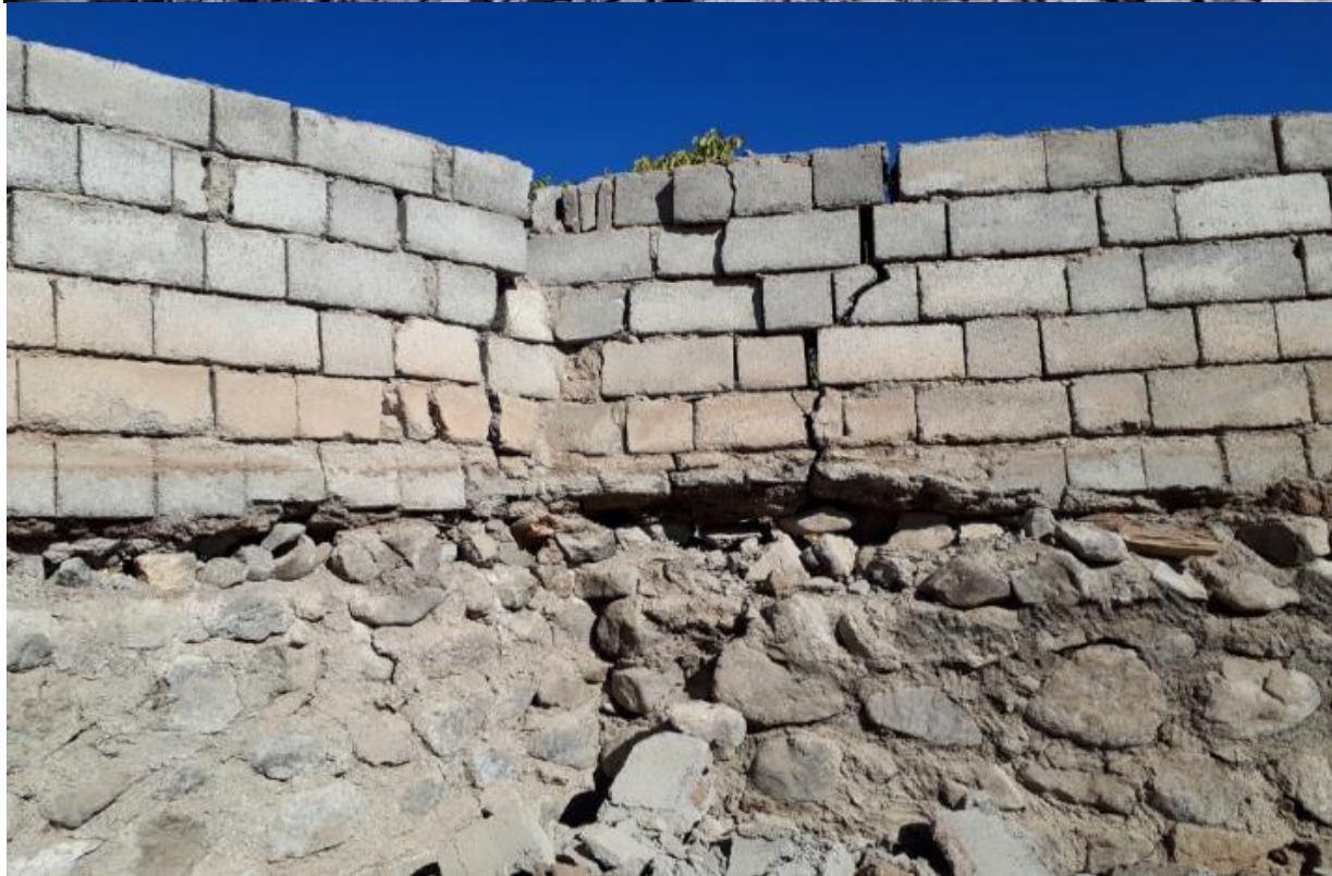
شکل ۱۰-۲ آسیب دیدگی و تخریب دیوار حیاط منازل
