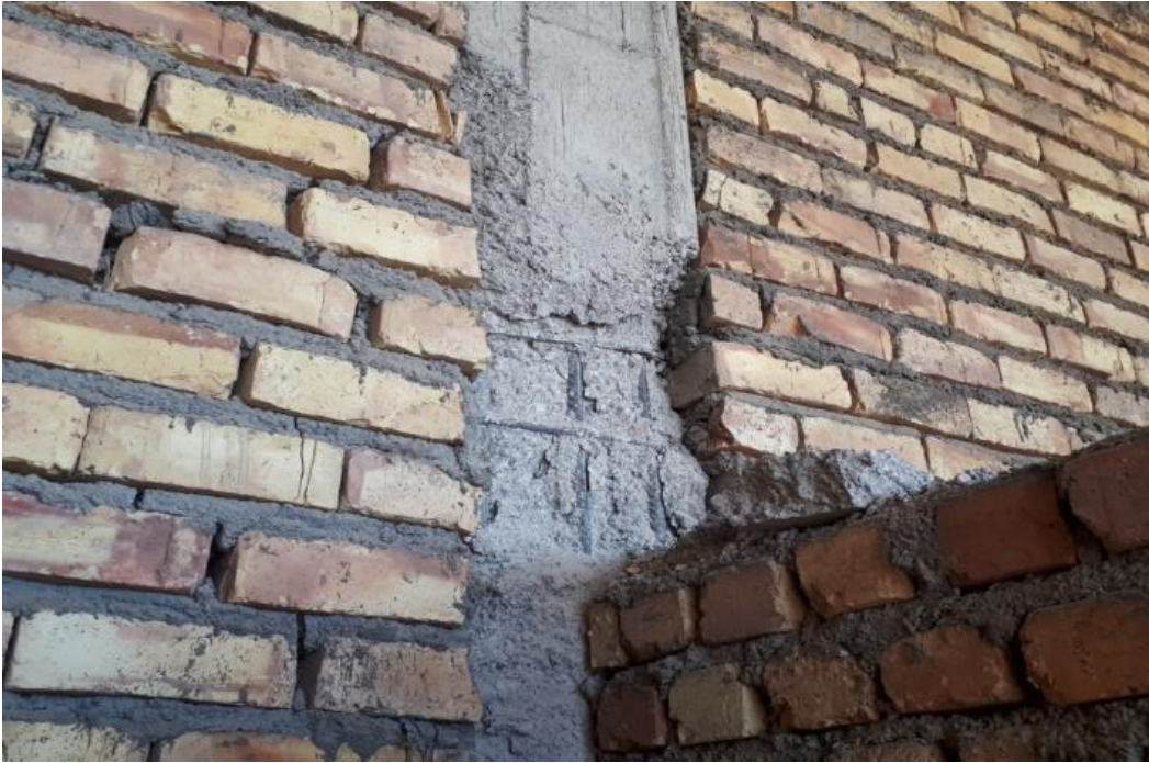
شکل ۴۵-۲ بروز تخریب در کاور بتن ستون در ساختمان اسکلت بتنی دو طبقه
