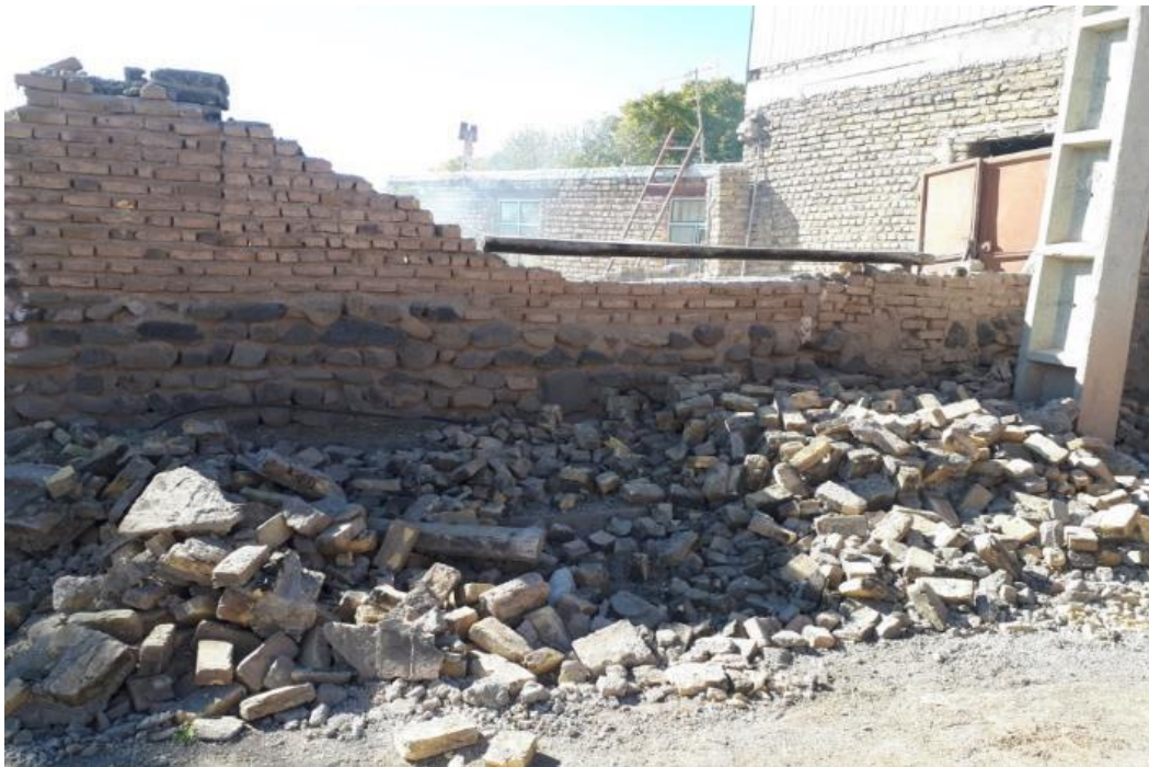
شکل ۲۵-۲ واژگونی و ریزش مصالح دیوار در روستای ورنکش
