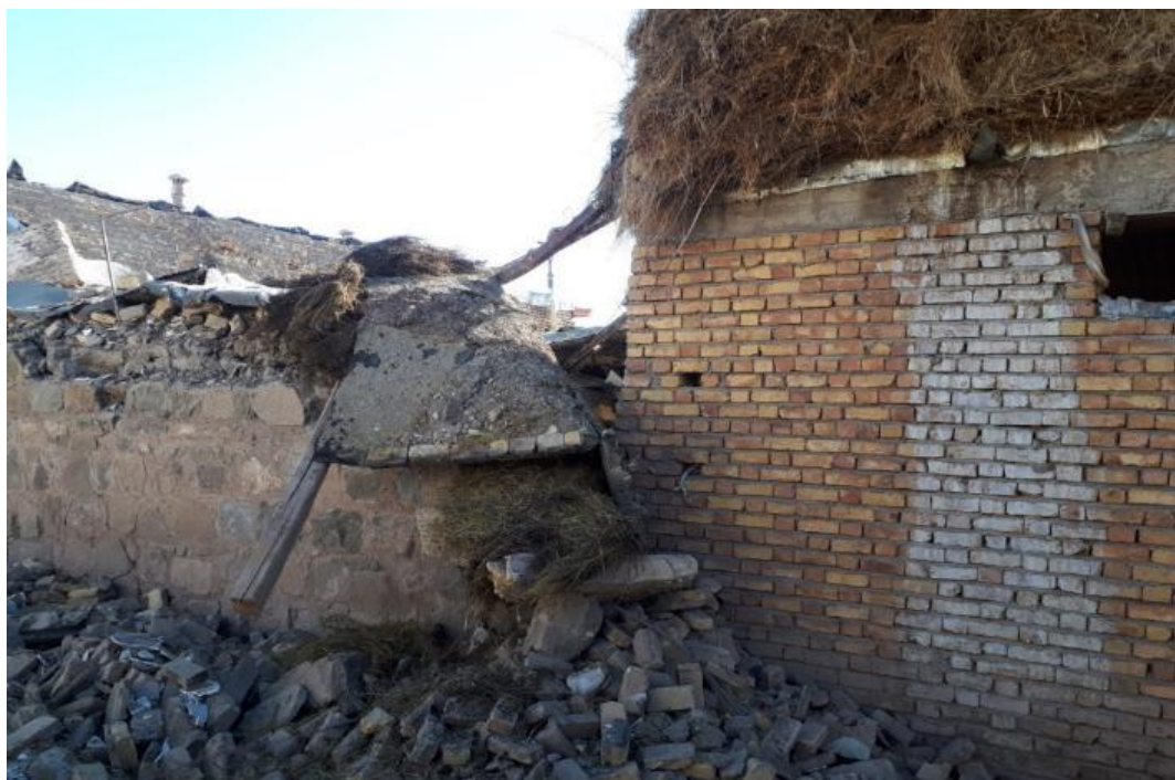
شکل ۴۳-۲ مقایسه رفتار لرزه ای سازه بنایی کلافدار و بدون کلاف در ورنکش (تخریب کامل سازه بدون کلاف)
