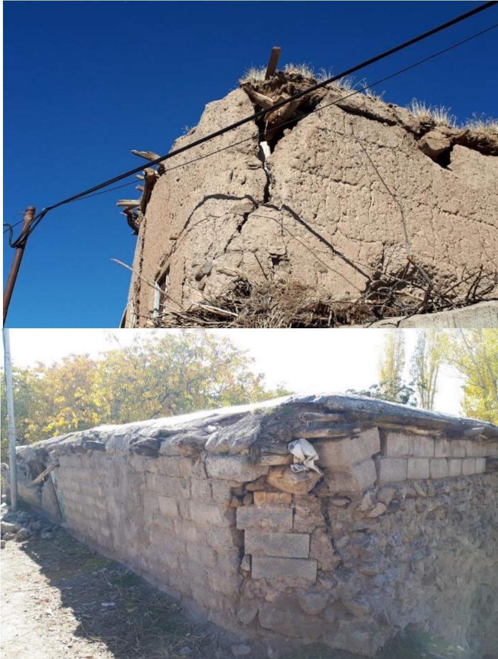
شکل ۱۲-۲ بروز تخریب گوشه در ساختمان های خشتی و سنگی
