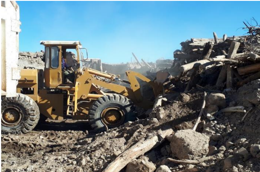
شکل ۶۱-۲ حجم بالای تخریب در بافت منازل خستی و گلی روستای تیرشاب
