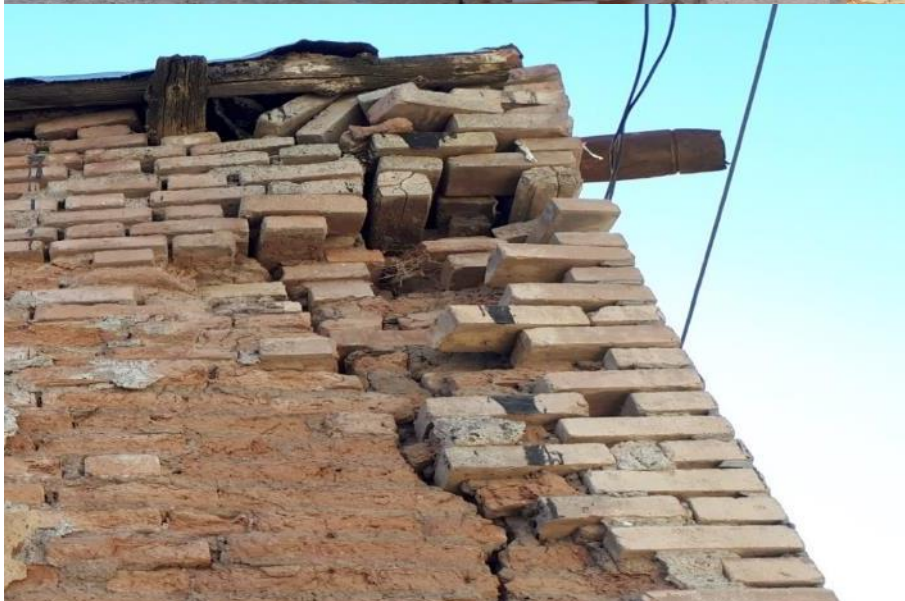
شکل ۷-۲ بروز گسیختگی بین دیوارهای متعامد
