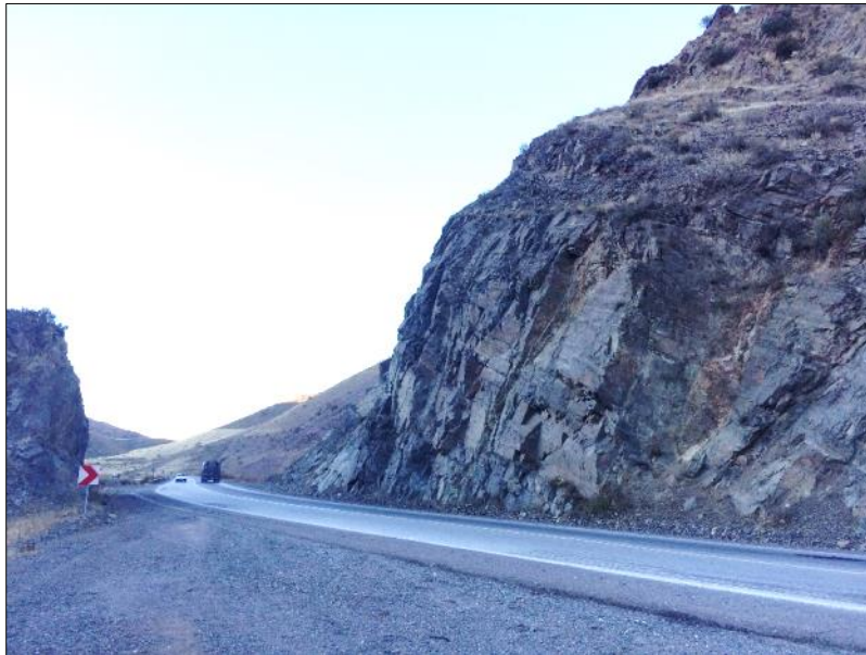
شکل ۱-۲۰ یکی از نقاط ریزش کوه در جاده میانه - ترکمانچای که توسط نیروهای راهداری میانه پاکسازی شده است.
