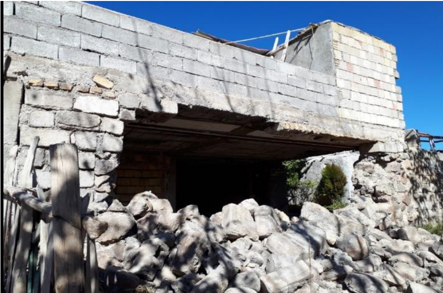
شکل ۱۵-۲ ریزش مصالح دیوار ساختمان اسکلت بتونی در روستای بالسین
