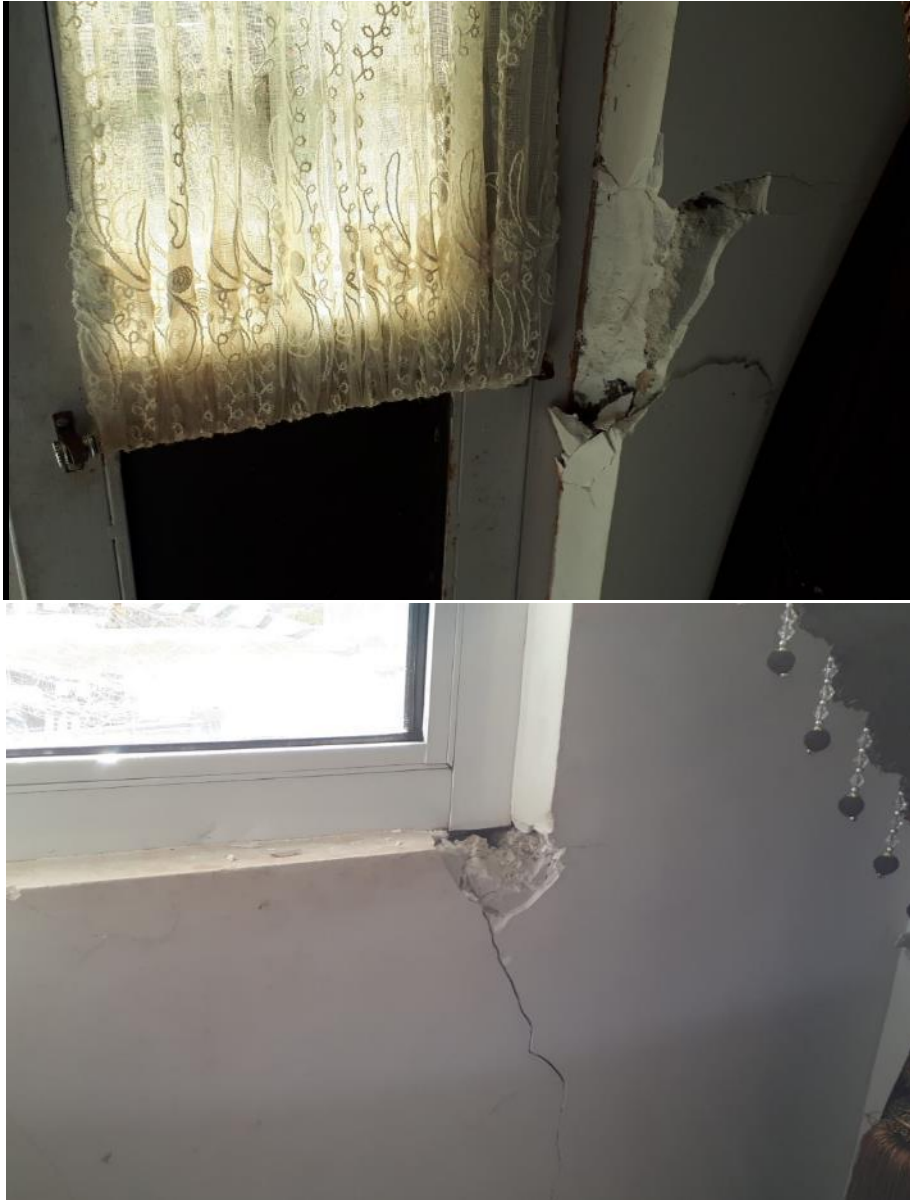
شکل ۲۳-۲ آسیب های اندک در ساختمان های اسکلت دار در منطقه بالسین
