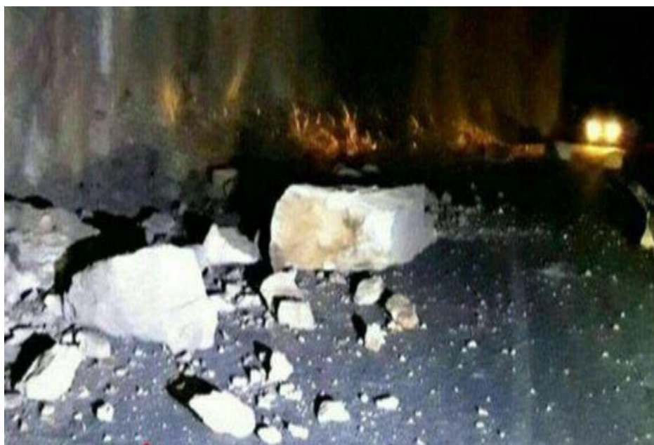
شکل ۸-۳ ریزش سنگ و انسداد مسیر در محور میانه - بستان آباد
