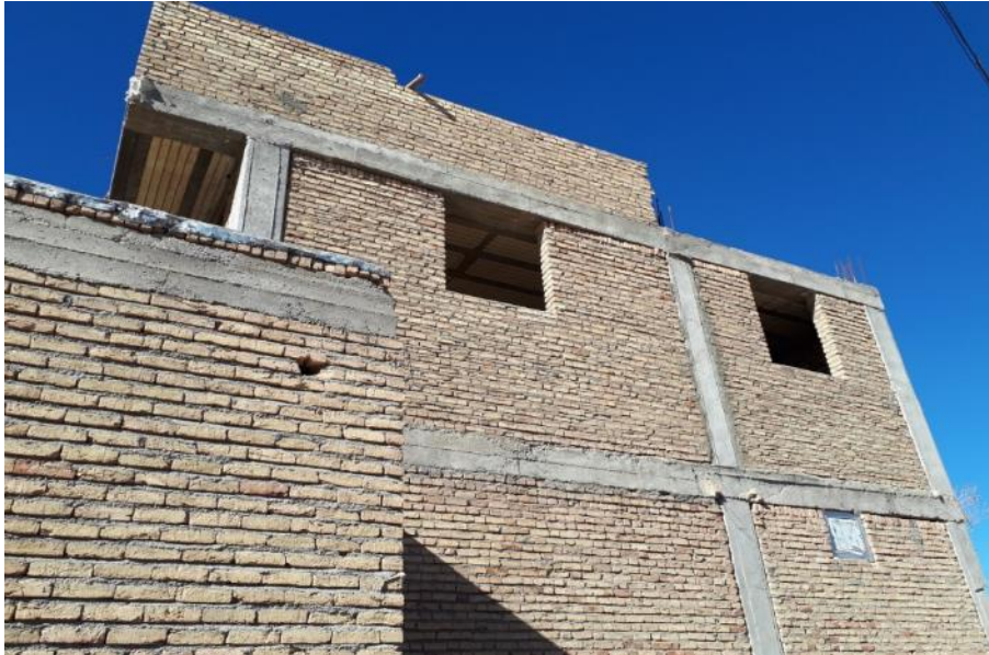
شکل ۲-۷۷ عملکرد مطلوب لرزه ای ساختمان های اسکلت دار (اسکلت بتنی) در هروان
