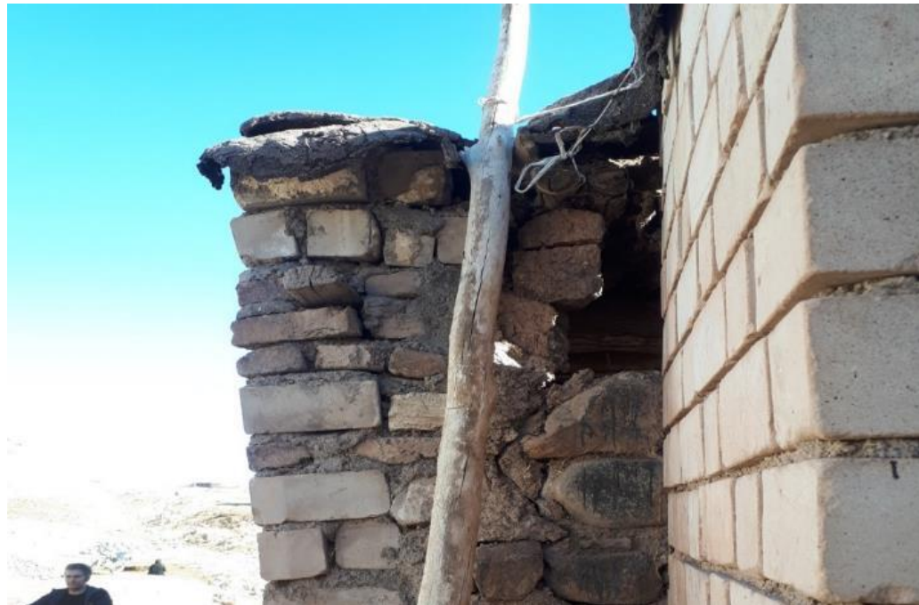
شکل ۳۰-۲ بروز گسیختگی بین دیوارهای متعامد در اثر حرکت جانبی دیوار و عدم اتصال کافی
