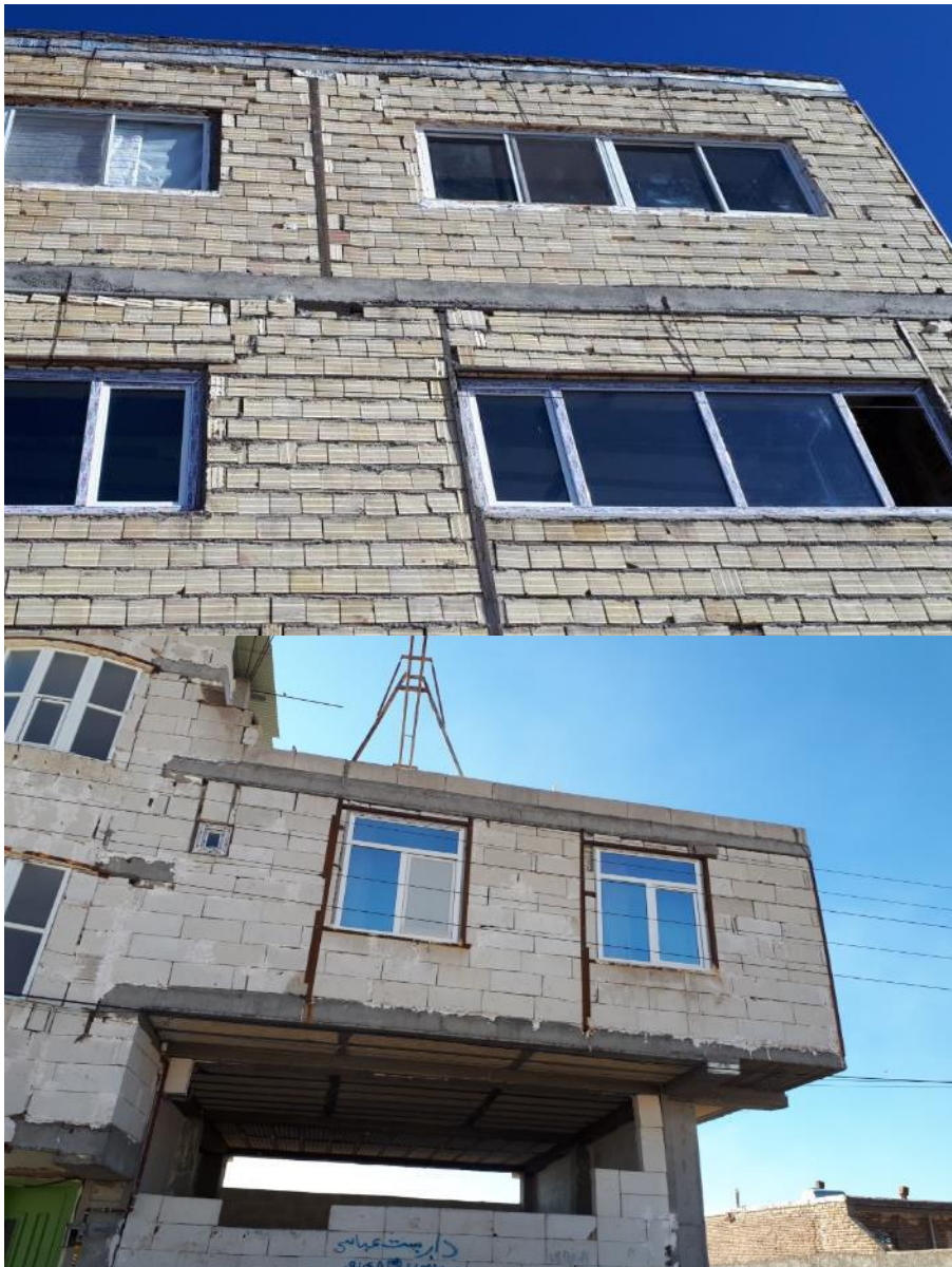
شکل ۱۸-۲ عدم ریزش مصالح دیوار در اثر استفاده از اتصالات و المان‌های نگهدارنده
