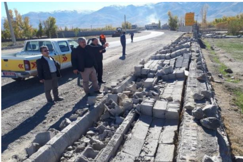
شکل ۲-۷۹ تخریب کامل دیوارهای محوطه برخی اماکن
