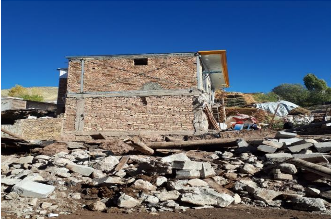
شکل ۴۲-۲ مقایسه رفتار لرزه ای سازه بنایی کلافدار (سازه کلافدار ترکیبی مغایر با ضوابط ۲۸۰۰+) و بدون کلاف (تخریب کامل سازه بدون کلاف)
