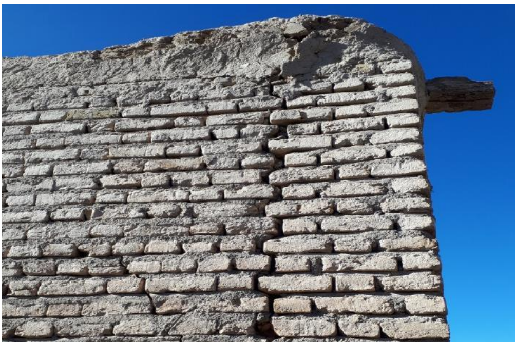
شکل ۲-۵۷ نمونه‌ای از بروز جداسدگی در دیوارهای متعامد (در اثر عدم اتصال مناسب بین دو دیوار)
