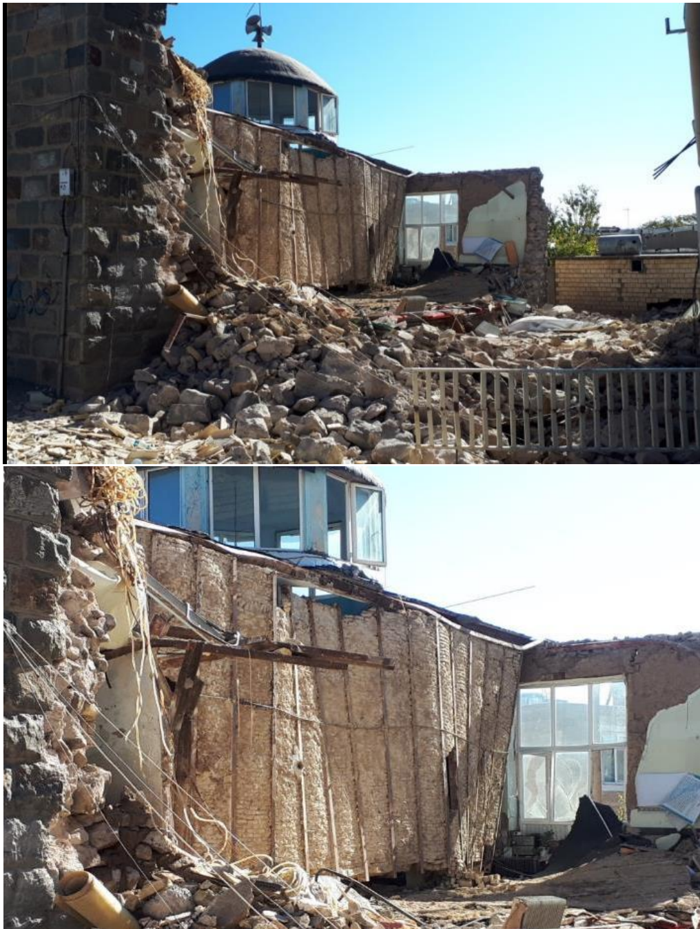
شکل ۲-۳۸ سقوط سقف طاق ضربی به دلیل تخریب دیوار تکیه گاهی و طول نشیمن اندک
