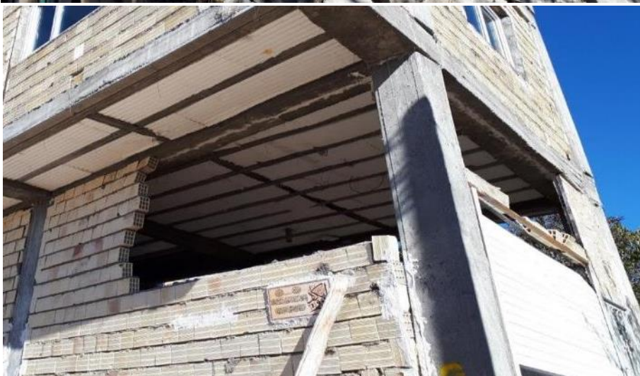
شکل ۱۶-۲ ریزش دیوارها در برخی از ساختمان های اسکلت دار روستای بالسین
