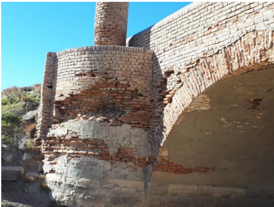
شکل ۱-۲ پل باستانی واقع در شهرستان سراب که در اثر زلزله آسیب دیده است.
