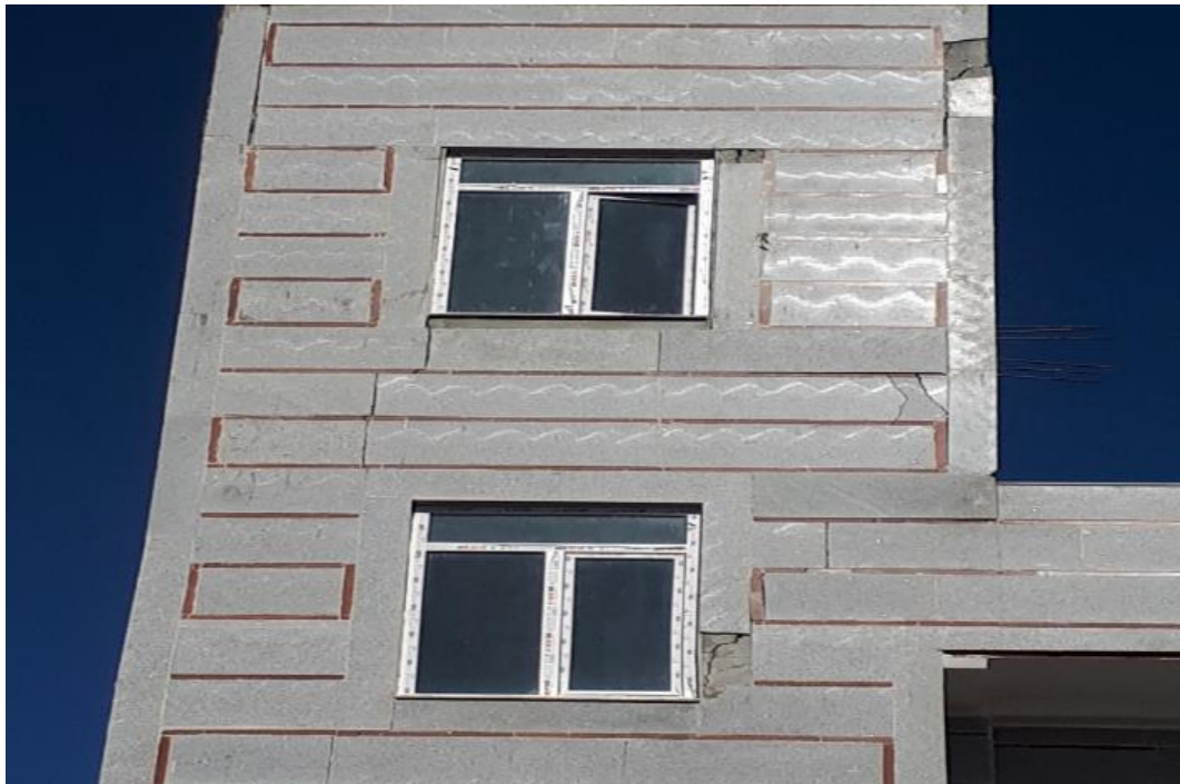
شکل ۵۳-۲ آسیب و ریزش مصالح نما در ساختمان اسکلت بتنی در ورنکش
