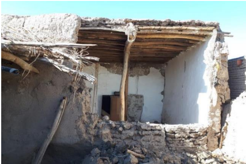
شکل ۷۲-۲ ریزش و واژگونی دیوار موازی تیرریزی سقف در سازه مصالح بنایی بدون کلاف
