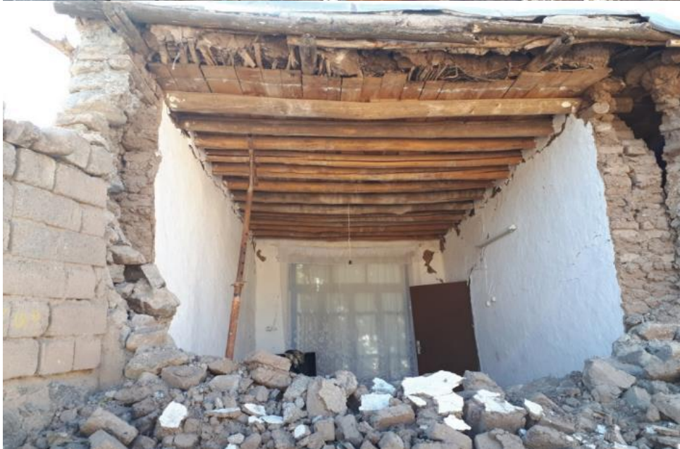
شکل ۸-۲ واژگونی و تخریب کامل دیوار در اثر عدم وجود اتصال کافی
