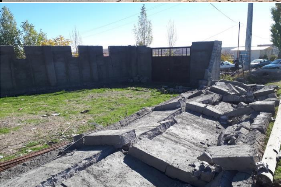
شکل ۲۶-۲ واژگونی چندین دیوار در روستای ورنکش و ضربه زدن به تاسیسات مجاور دیوار
