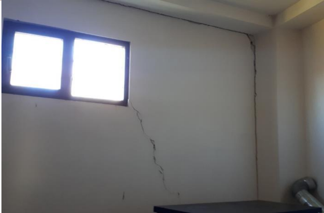
شکل ۲۲-۲ آسیب‌های اندک در ساختمان های اسکلت دار در منطقه بالسین
