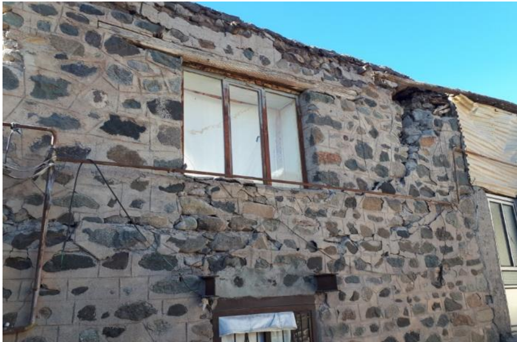
شکل ۳۴-۲ شکست برشی در دیوار سازه مصالح بنایی و ناپایداری کل ساختمان
