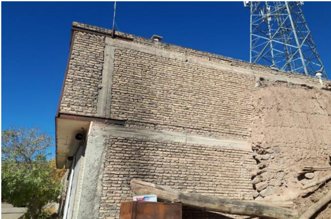
شکل ۴۰-۲ عملکرد مناسب لرزه ای سازه بنایی کلافدار در منطقه ورنکش
