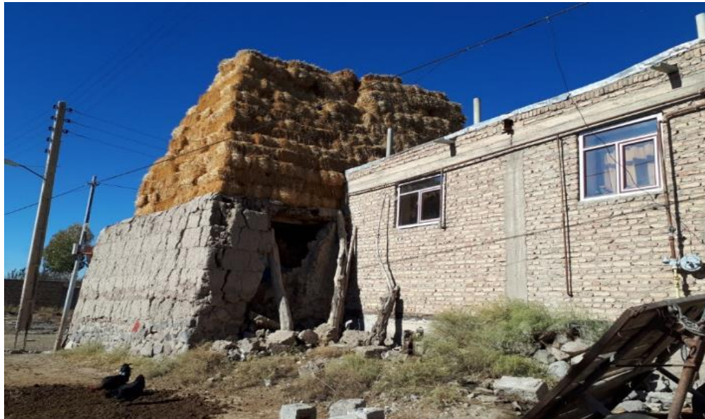
شکل ۷۶-۲ عملکرد مطلوب لرزه ای سازه های بنایی کلاف دار در هروان
