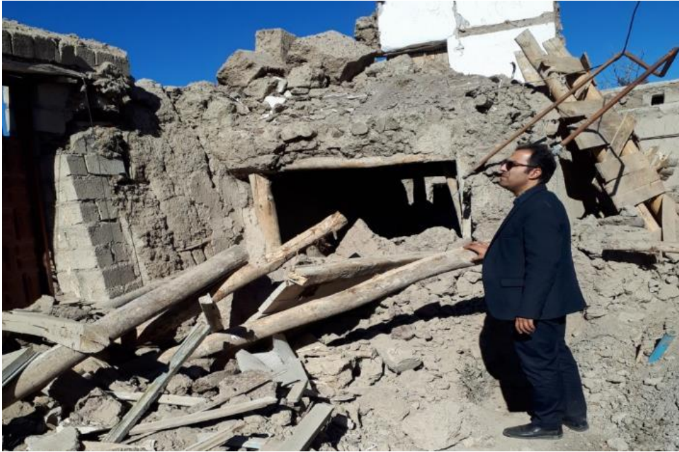
شکل ۲-۵۶ نمونه ای از تخریب های ساختمان های خشتی و گلی روستای تیرشاب (تخریب کامل)
