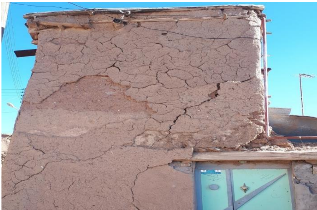
شکل ۲-۳۳ شکست برشی در دیوار سازه مصالح بنایی و ناپایداری کل ساختمان
