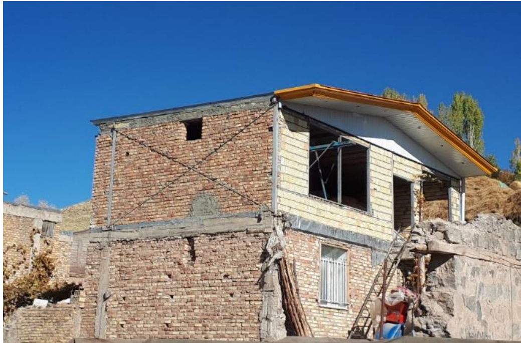
شکل ۴۱-۲ عملکرد مناسب لرزه ای سازه بنایی کلافدار در منطقه ورنکش
