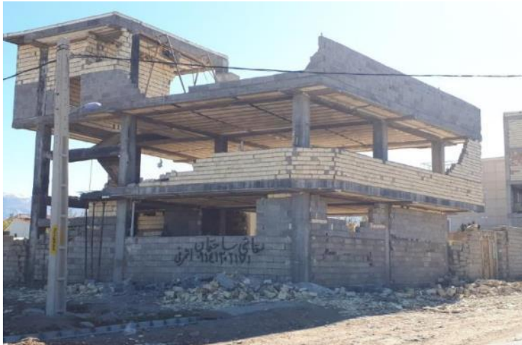
شکل ۸۲-۲ ریزش دیوار ساختمان در اسب فروشان در اثر عدم رعایت ضوابط اتصال
