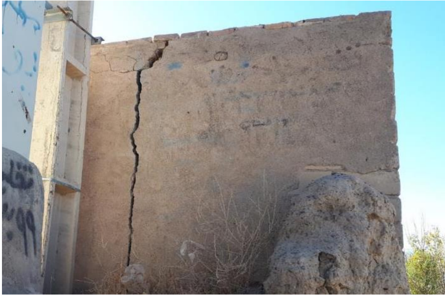
شکل ۶۹-۲ بروز ترک قائم در دیوار بنای آجری در روستای دونیق
