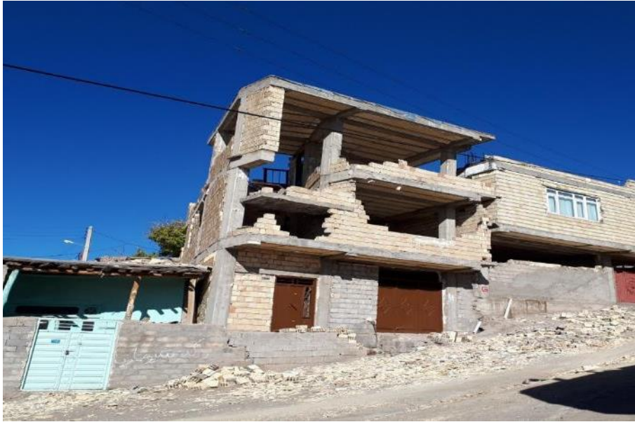
شکل ۱۵-۲ ریزش مصالح دیوار ساختمان اسکلت بتونی در روستای بالسین
