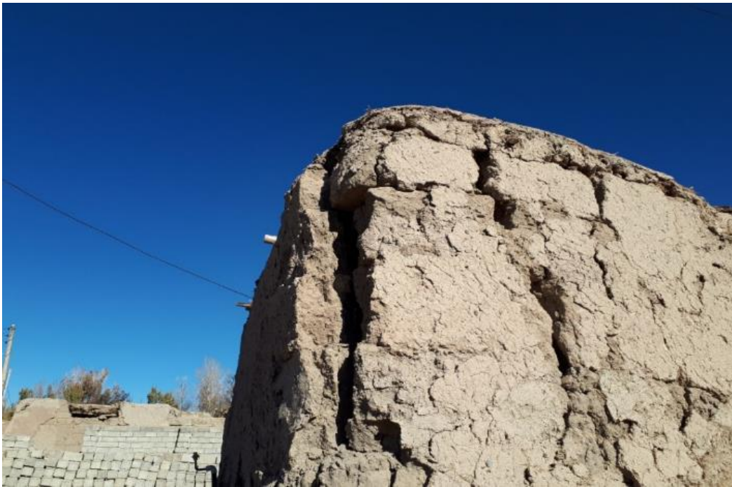
شکل ۲-۵۹ شکست گوشه در ساختمان گلی در روستای تیرشاب
