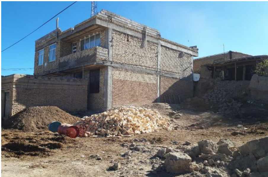
شکل ۷۰-۲ عملکرد مطلوب سازه اسکلت بتنی در کنار تخریب سازه بنایی خشتی و گلی در روستای دونیق
