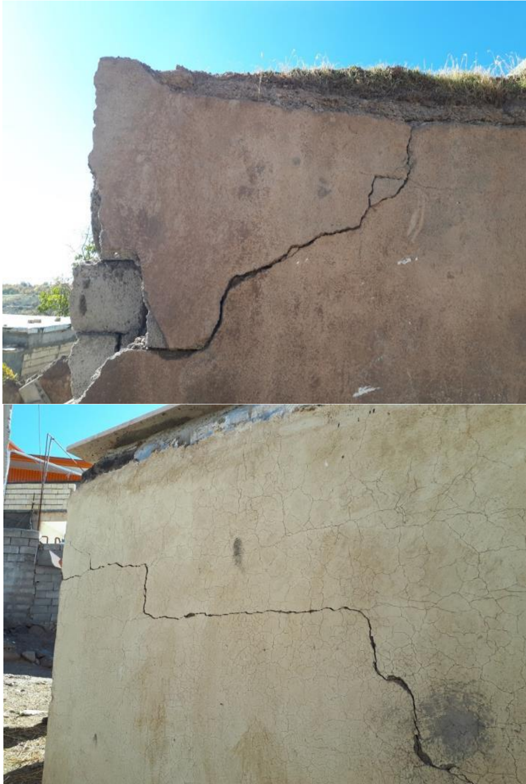
شکل ۵-۲ بروز ترک برشی در دیوار ساختمان مصالح بنایی
