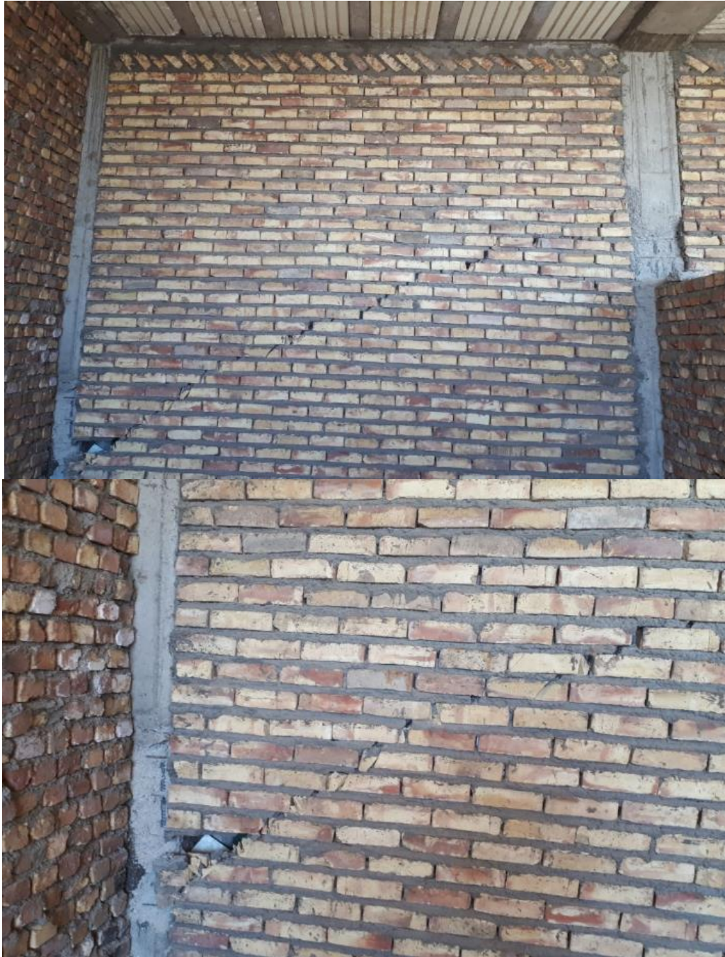
شکل ۴۴-۲ بروز ترک برشی در دیوار و تخریب کاور بتن در ستون‌های مجاور
