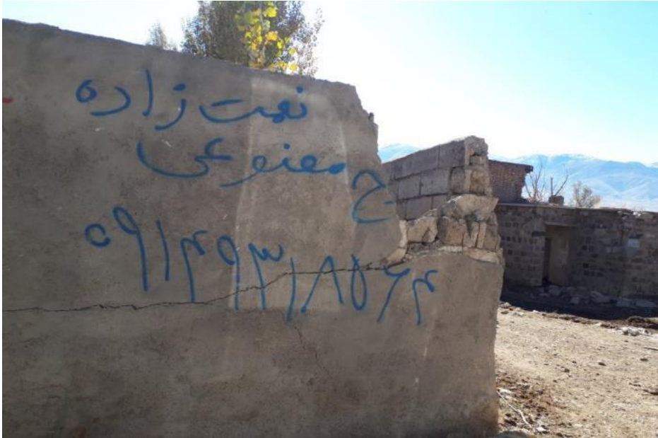
شکل ۲-۷۴ تخریب و واژگونی برخی دیوارهای محوطه ها در هروان
