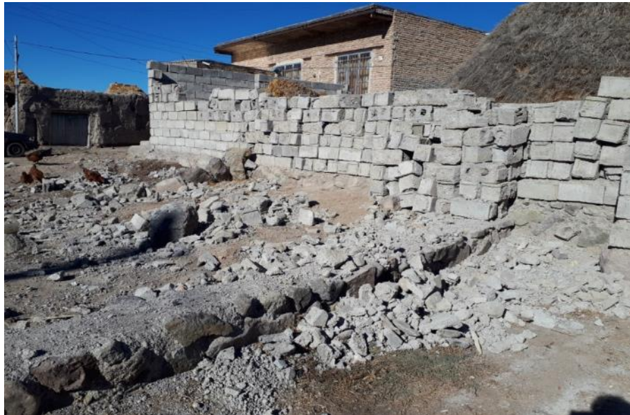
شکل ۶۲-۲ ریزش دیوارهای محوطه ها در اثر زلزله
