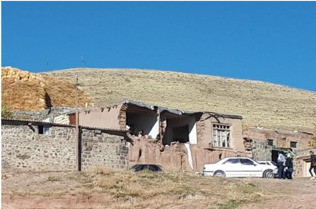
شکل ۳۶-۲ تخریب دیوار موازی تیرریزی سقف به دلیل عدم اتصال مناسب با سقف
