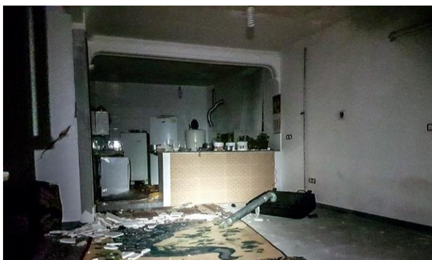
شکل ۱۲-۳ قطع لوله بخاری و آبگرمکن یکی از منازل بعد وقوع زلزله
