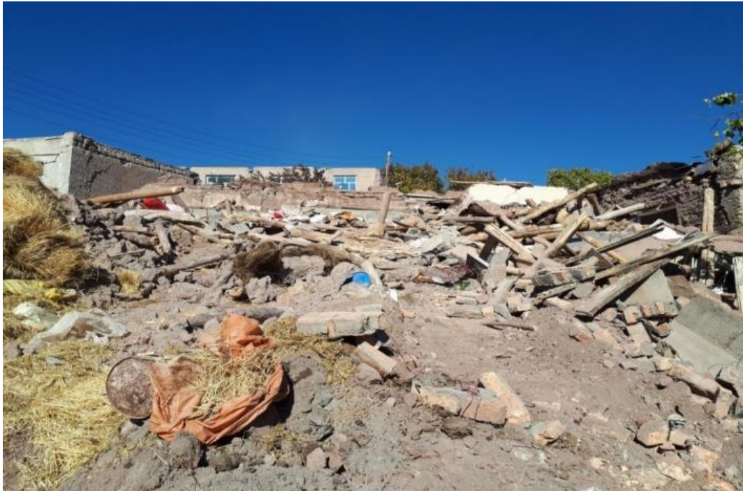
شکل ۲۸-۲ تخریب کامل ۳۰ سازه بنایی بدون کلاف در ورنکشن
