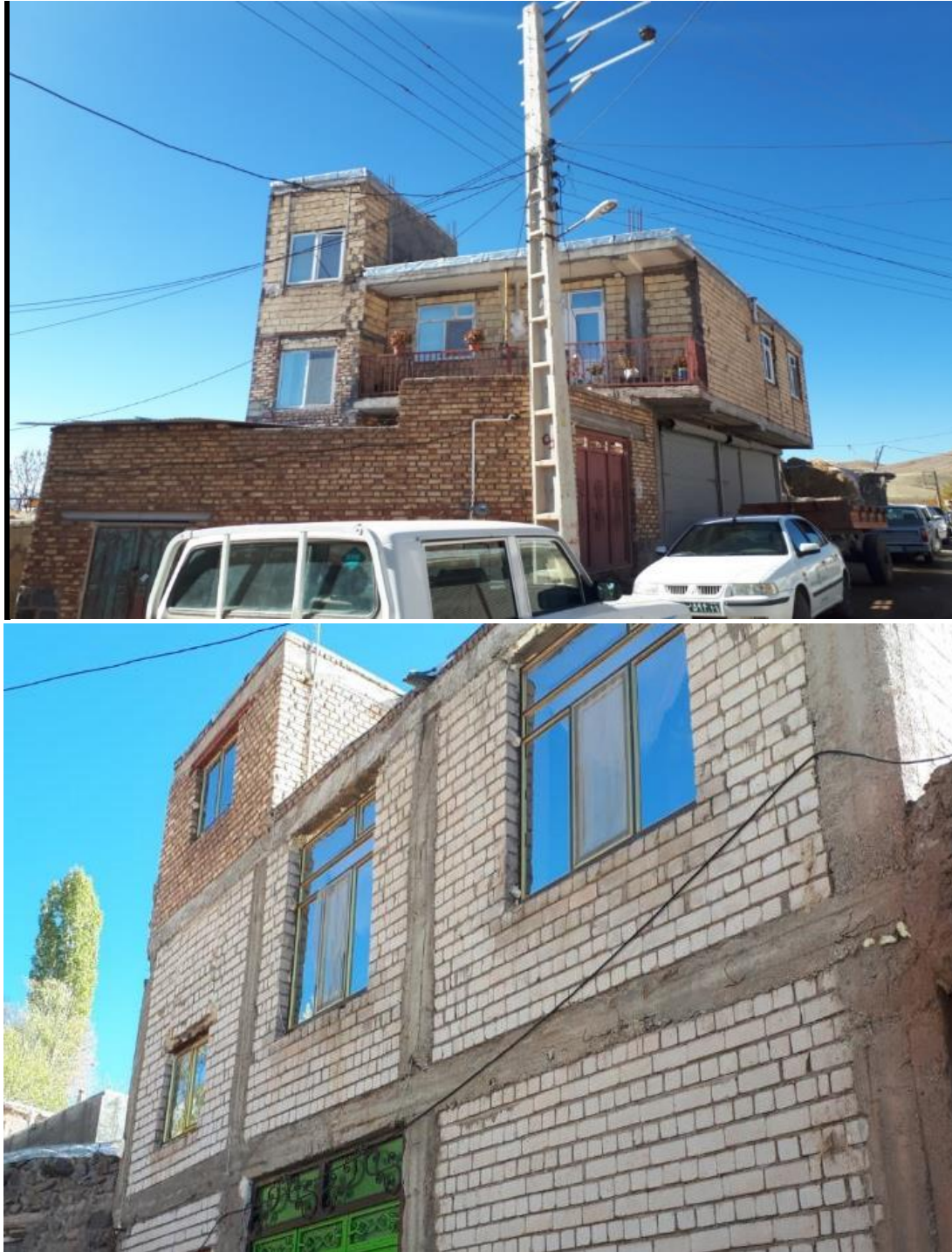
شکل ۴۷-۲ عملکرد لرزه ای مناسب سازه های دارای اسکلت و آسیب دیدگی بسیار جزئی
