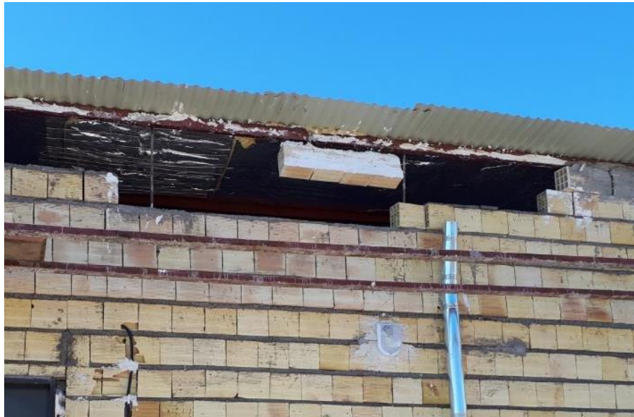
شکل ۲۱-۲ بروز ترک و ریزش مصالح دیوار در طبقه فوقانی ساختمان
