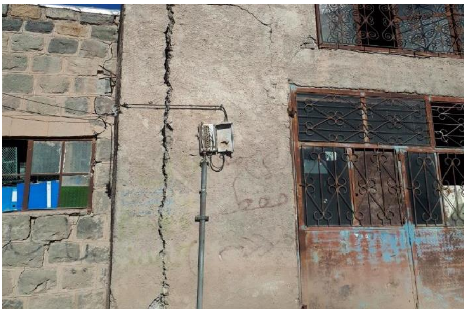
شکل ۳۲-۲ تخریب گوشه در سازه بنایی قدیمی
