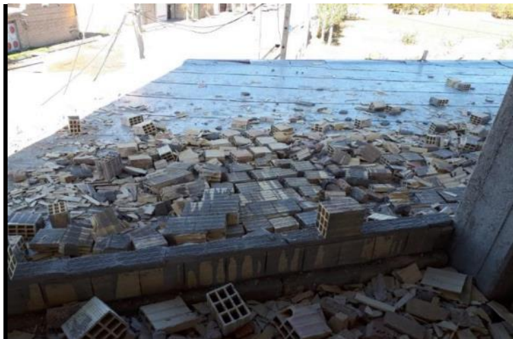
شکل ۸۱-۲ تخریب در دیوار حد فاصل دو بازشو، به دلیل عدم رعایت ابعاد و هندسه بازشوها
