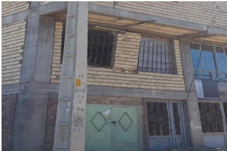
شکل ۸۱-۲ تخریب در دیوار حد فاصل دو بازشو، به دلیل عدم رعایت ابعاد و هندسه بازشوها
