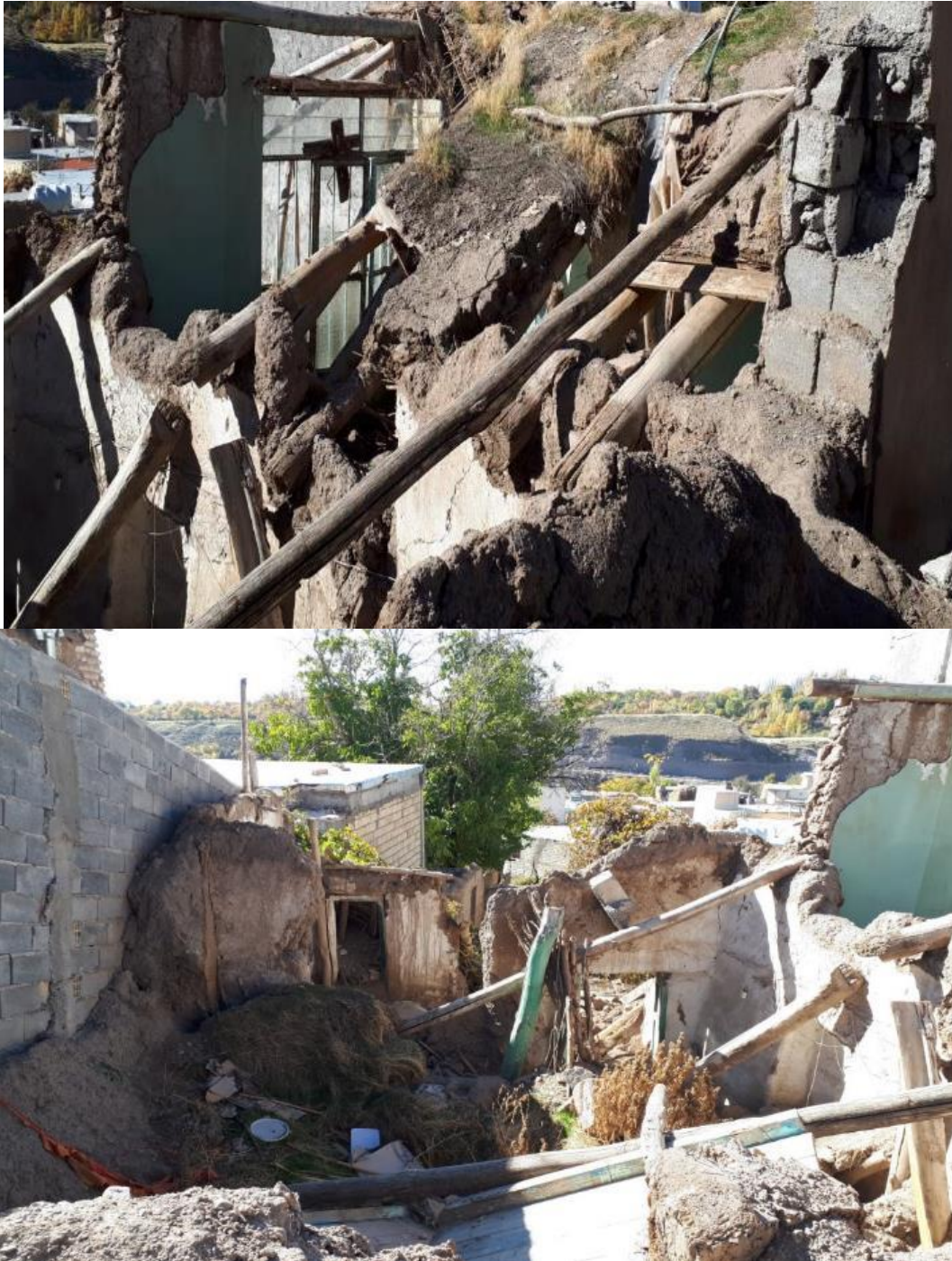
شکل ۱۳-۲ بروز تخریب (سقوط سقف) در اثر سنگینی سقف و فاصله زیاد تیرهای چوبی
