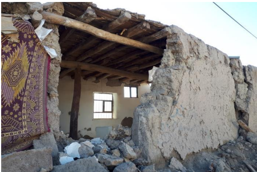
شکل ۶۸-۲ واژگونی و تخریب دیوار سازه مصالح بنایی بدون کلاف در روستای دونیق
