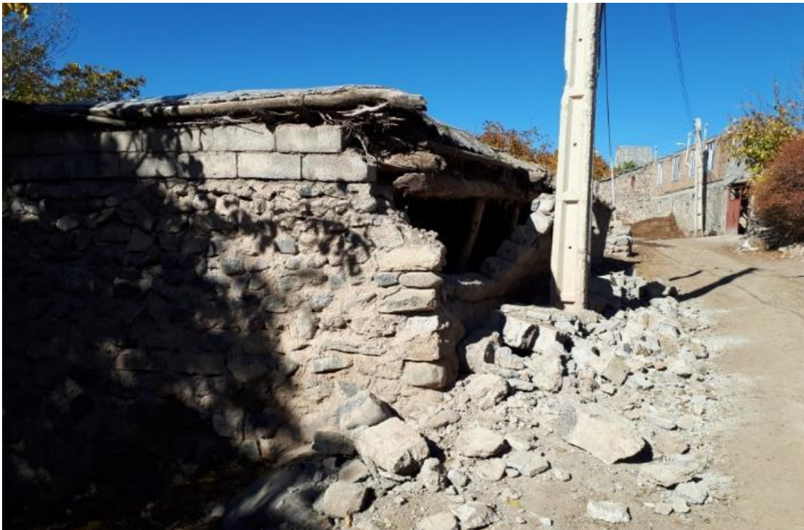
شکل ۹-۲ واژگونی و تخریب کامل دیوارهای موازی تیرریزی در اثر عدم وجود اتصال کافی با سقف و عدم وجود بار ثقلی سقف روی آنها
