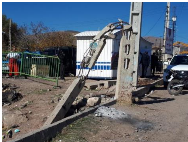
شکل ۱۳-۳ قطع تیر برق در منطقه زلزله زده
