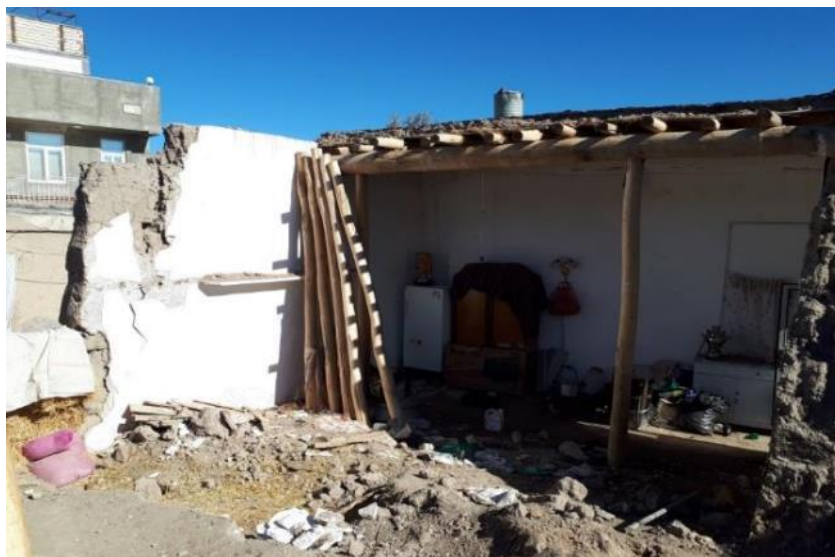
شکل ۷۳-۲ تخریب کامل سازه بنایی بدون کلاف
