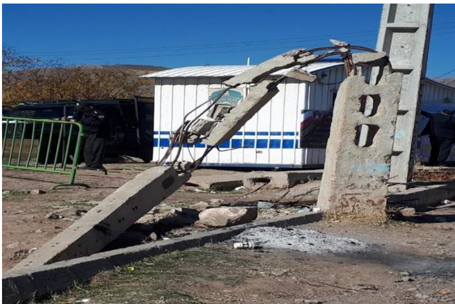
شکل ۵۴-۲ تخریب تیر برق در اثر زلزله در ورنکش
