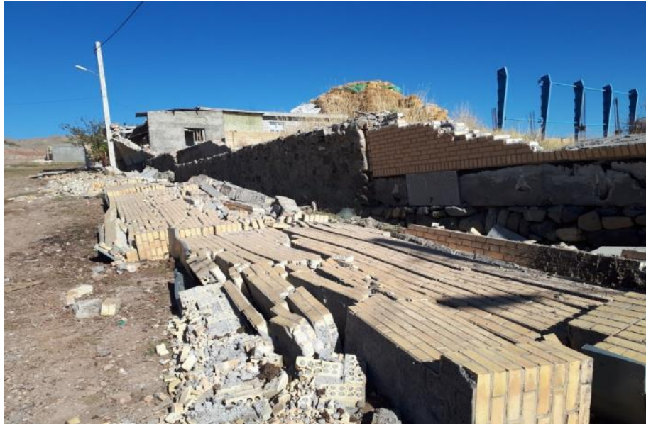
شکل ۲۷-۲ واژگونی چندین دیوار در روستای ورنکش و ضربه زدن به تاسیسات مجاور دیوار
