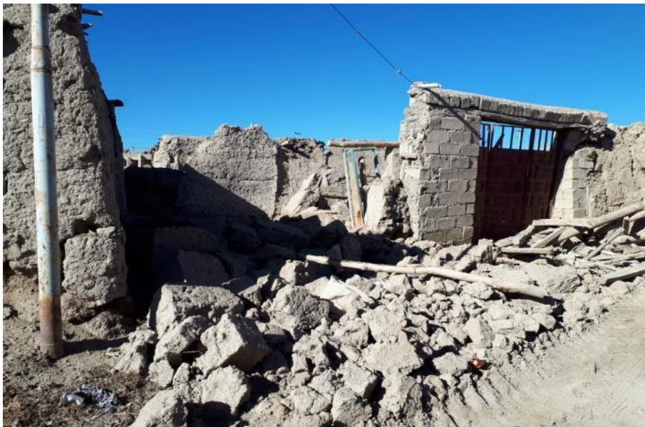
شکل ۲-۵۵ نمونه ای از تخریب های ساختمان های خشتی و گلی روستای تیرشاب
