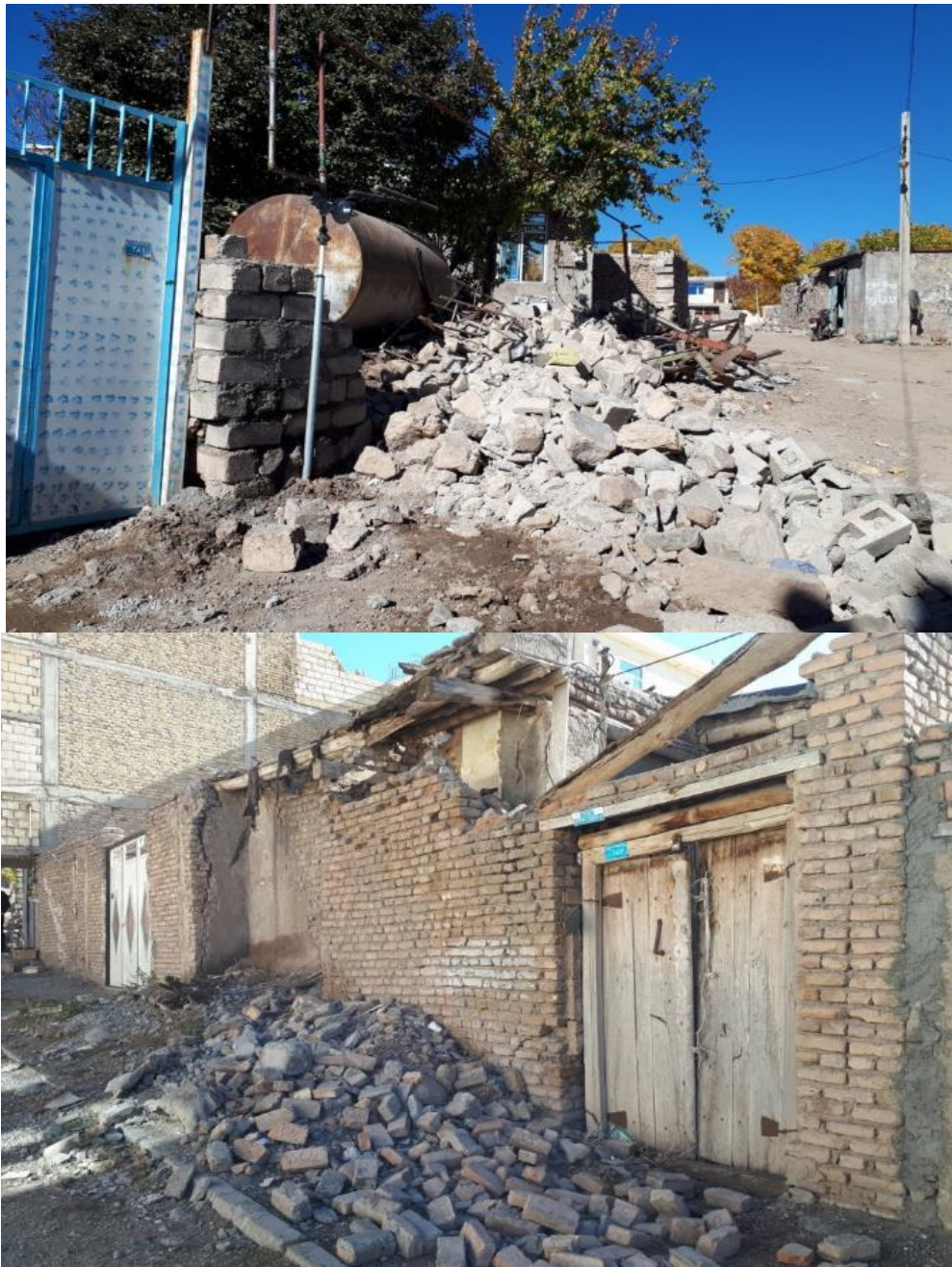
شکل ۱۱-۲ ریزش دیوار حیاط منازل در اثر حرکت جانبی و عدم وجود عناصر نگهدارنده جانبی
