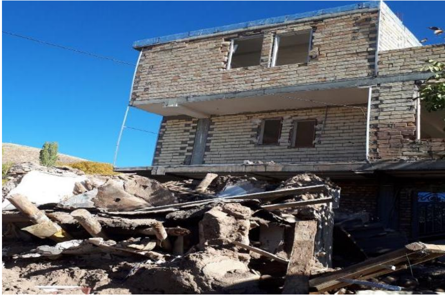
شکل ۴۸-۲ مقایسه رفتار لرزه ای سازه بنایی بدون کلاف و سازه اسکلت دار در ورنکش
