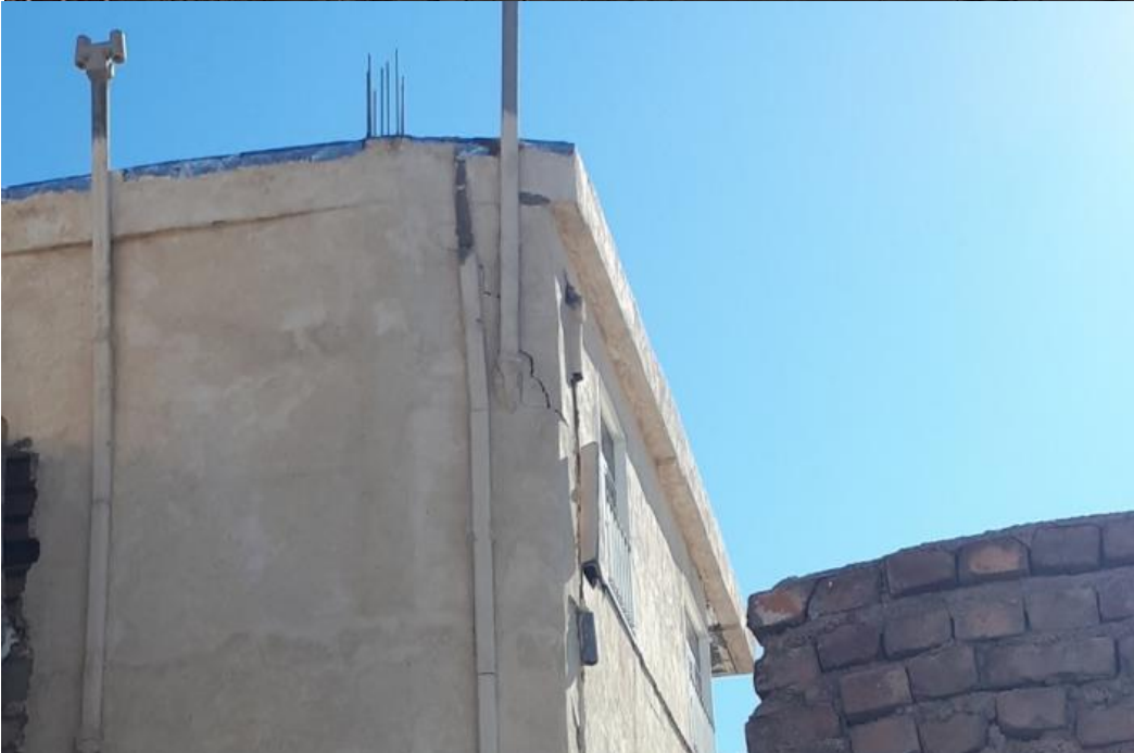
شکل ۲۰-۲ بروز تخریب در گوشه و محل تقاطع دیوارهای متعامد در محل اجرای دیوار خارج از قاب
