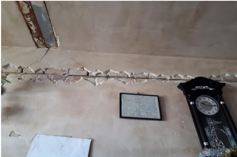
شکل ۶۳-۲ بروز ترک افقی در ساختمان بنایی آجری
