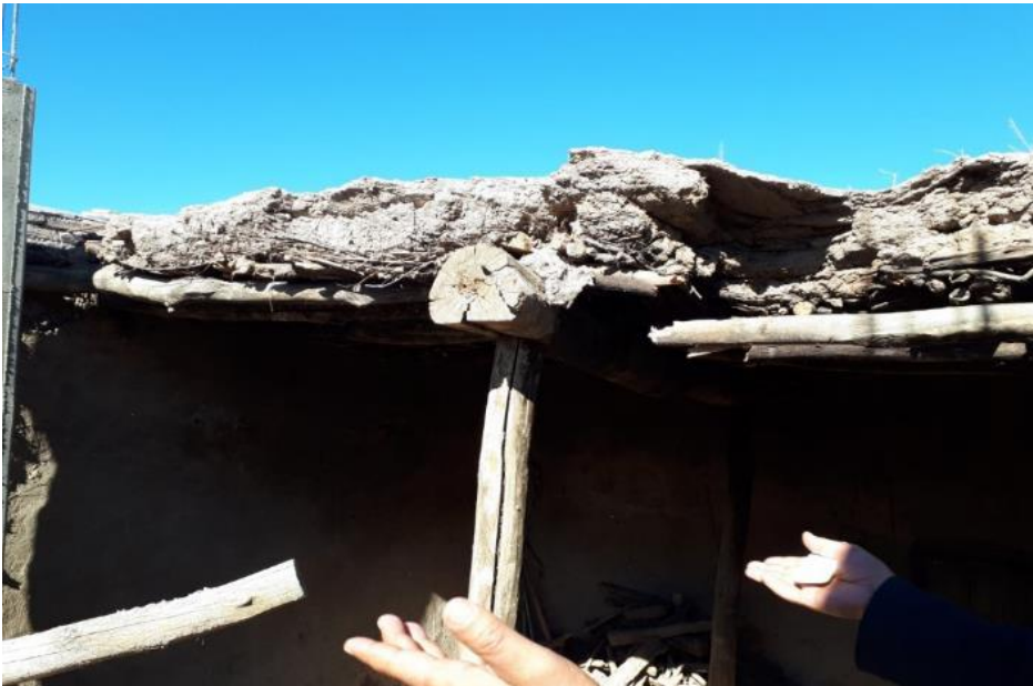
شکل ۲-۷۵ تخریب کامل سازه بنایی بدون کلاف
