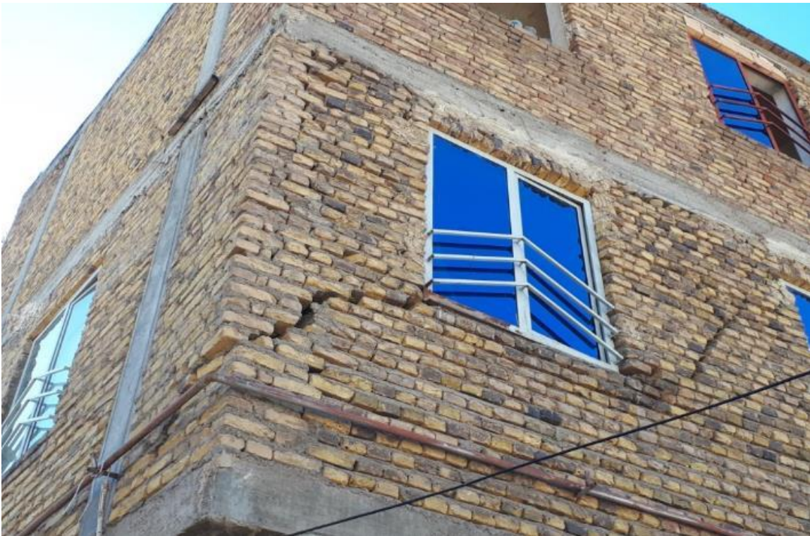
شکل ۱۹-۲ بروز تخریب و تضعیف شدید دیوار پیرامونی
