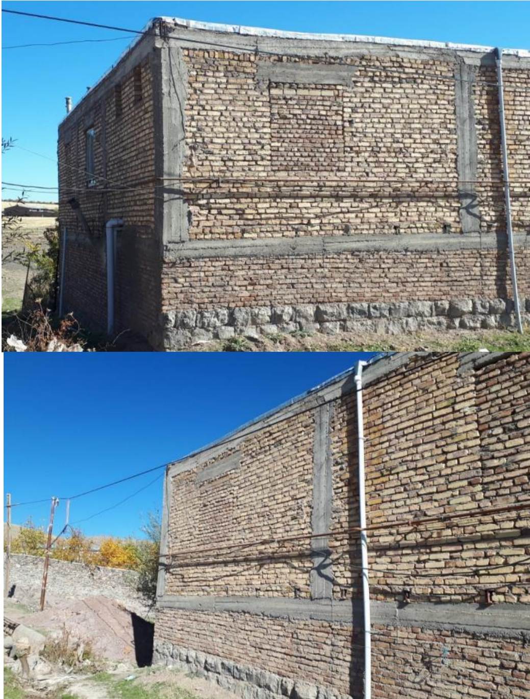
شکل ۳۹-۲ عملکرد مناسب لرزه ای سازه بنایی کلافدار در منطقه ورنکش
