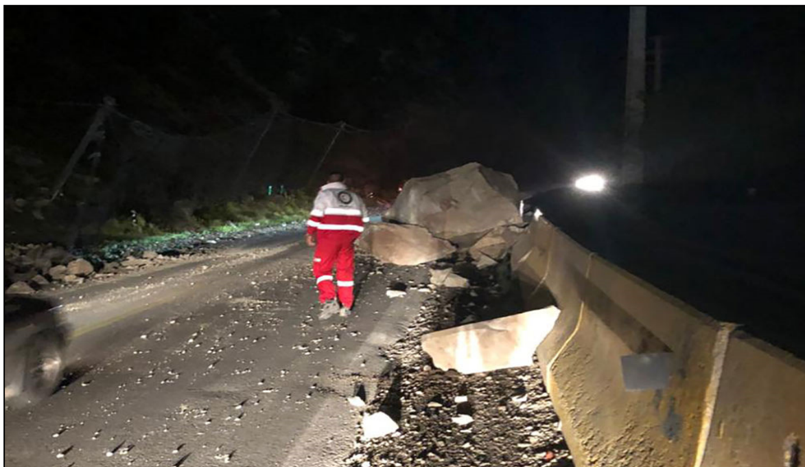
شکل ۲۹- ریزش در محور هراز در محدوده شهر آبعلی در اثر زلزله
