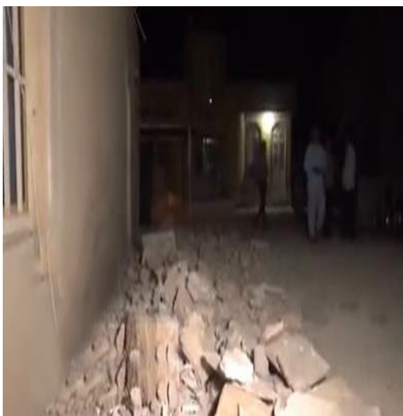
شکل ۱۲-۷- ریزش برخی از دیوارهای محوطه ها و منازل مسکونی در اثر زلزله
