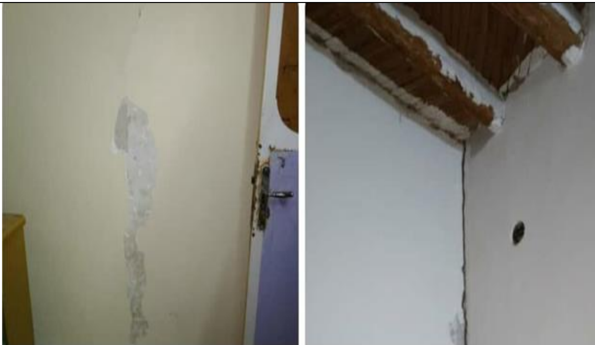
شکل ۱۲-۵-الف- بروز ترک خوردگی و ریزش در دیوار برخی منازل مسکونی در بیرم
