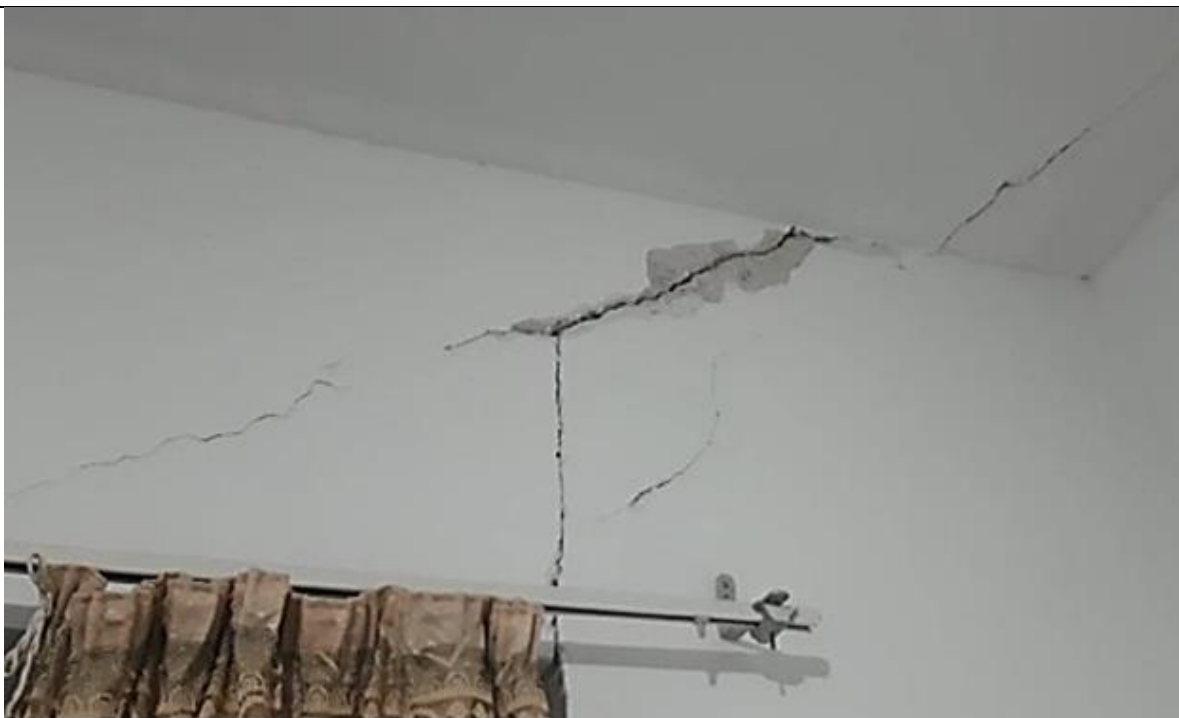
شکل ۱۲-۶- بروز ترک خوردگی و ریزش در دیوار برخی منازل مسکونی در خلیلی
