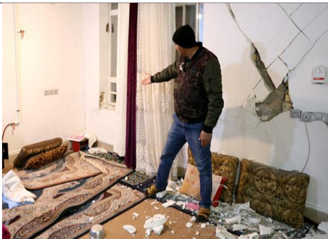
شکل ۱۲-۵-ب- بروز ترک خوردگی و ریزش در دیوار برخی منازل مسکونی در بیرم
