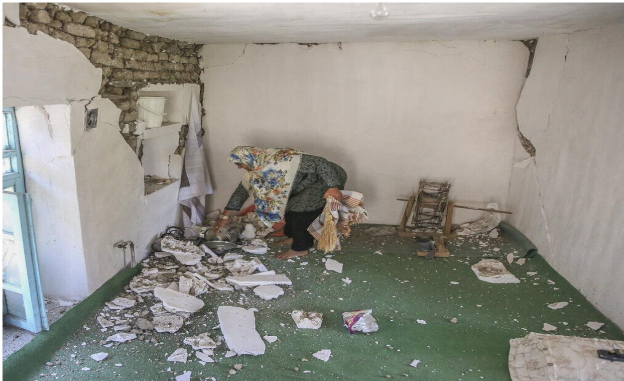
شکل ۲-۲- بروز ترک، گسیختگی و ریزش مصالح در دیوار ساختمان خشت و گلی
