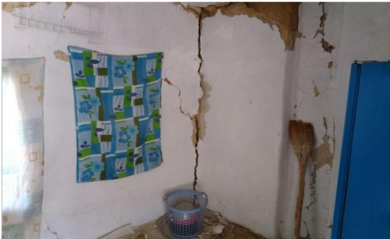
شکل ۲-۱- بروز ترک خوردگی در نقطه تلاقی دو دیوار برابر خشتی
