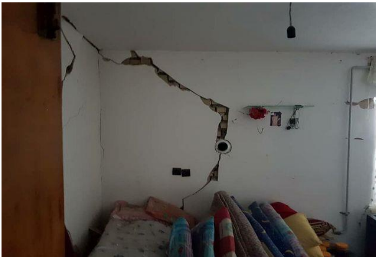
شکل ... بروز ترک خوردگی در دیوار منزل روستایی
